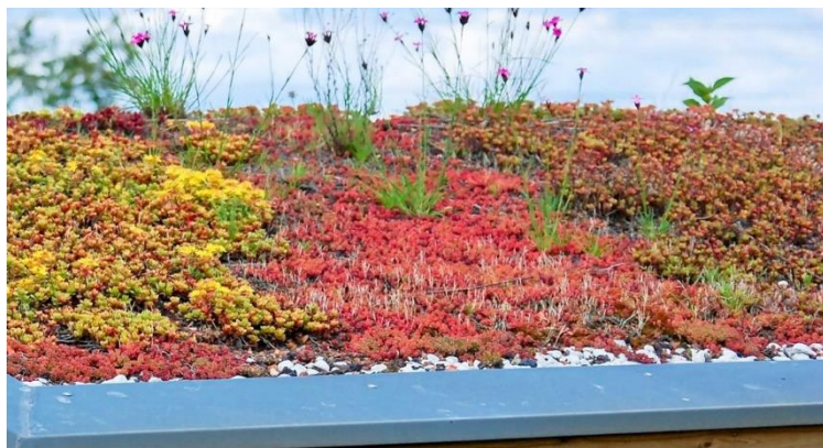
Sedumtak – hjälper till att fördröja regnvattenavrinning
