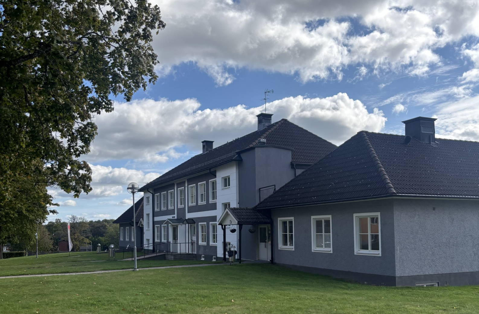
FASAD MOT NANNYLUNDGATAN – PUTSAD FASAD, TEGELTÄCKT SADELTAK
