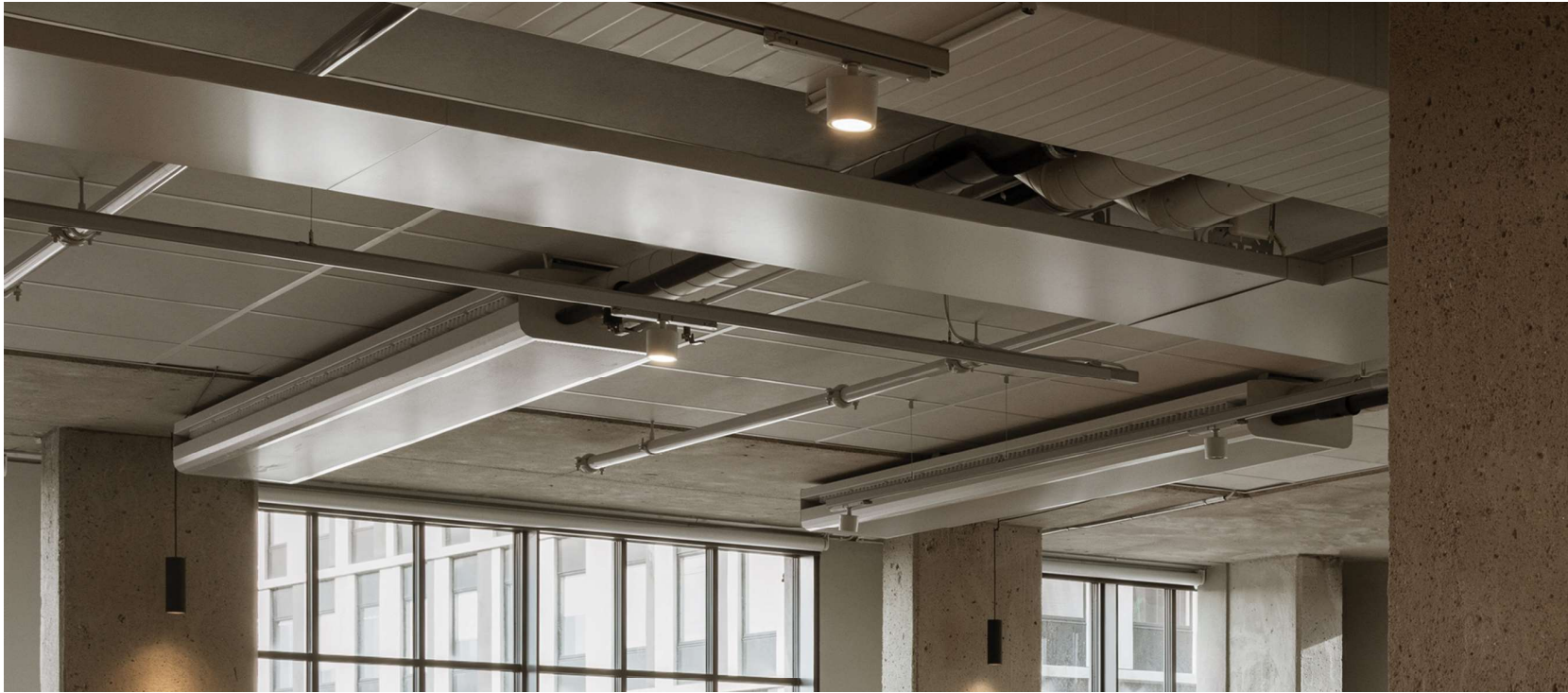
Referensbild, öppet tak med synliga installationer.
