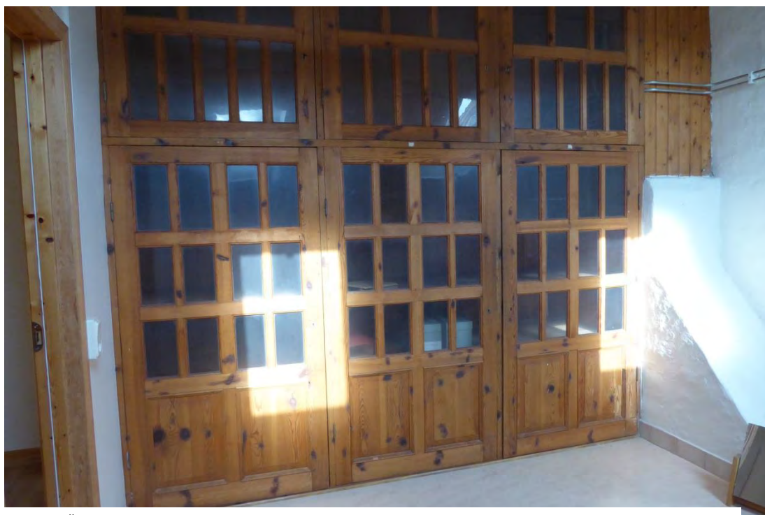
Figur 10 Över: Ett av de två små rummen som bildats genom att sätta igen delar av entréhallen/vestibulen. Nedan: Platsbyggt skåp på vindsvåningen.
