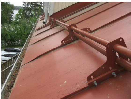
Yttertaket i falsad plåt
