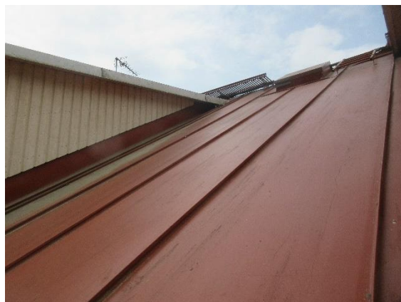
Yttertaket och kuporna från 2019
