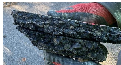
Figur 6. Bild av underliggande lager äldre asfalt.
