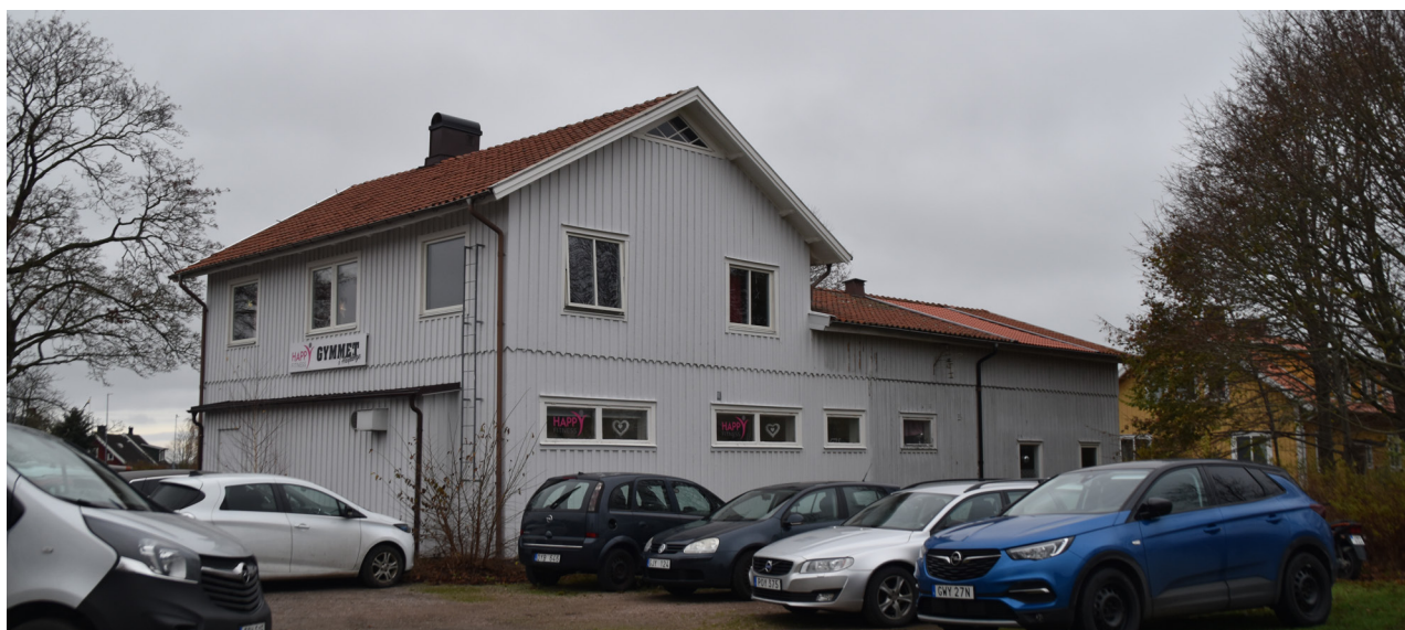
Byggnaden sedd från sydost (ovan) och väster (nedan till vänster). Hela byggnaden har locklistpanel i en ljus grå kulör och röda lertegeltak. Byggnaden omges av en trädgård med gräsmatta och träd, främst mot tomtgränsen mot öster. Grusplanen i sydost och asfaltsplanen framför byggnaden i söder används till parkering.
