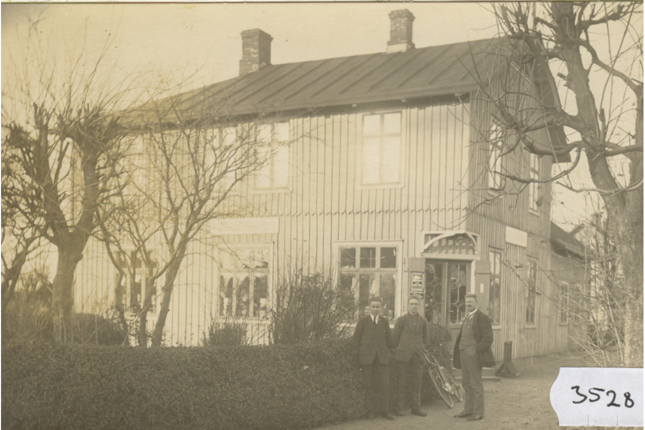
Harplinge handelsförenings affär med föreståndarebostad på den tillbyggda övervåningen. En del av huset, delar av bottenvåningen och vinkeln bakåt användes tidigare som magasin för Harplinge inköpsförening. Fotot är troligtvis taget runt 1910-talet efter tillbyggnaden av den andra våningen. Foto: Harplinge hembygdsförening.
