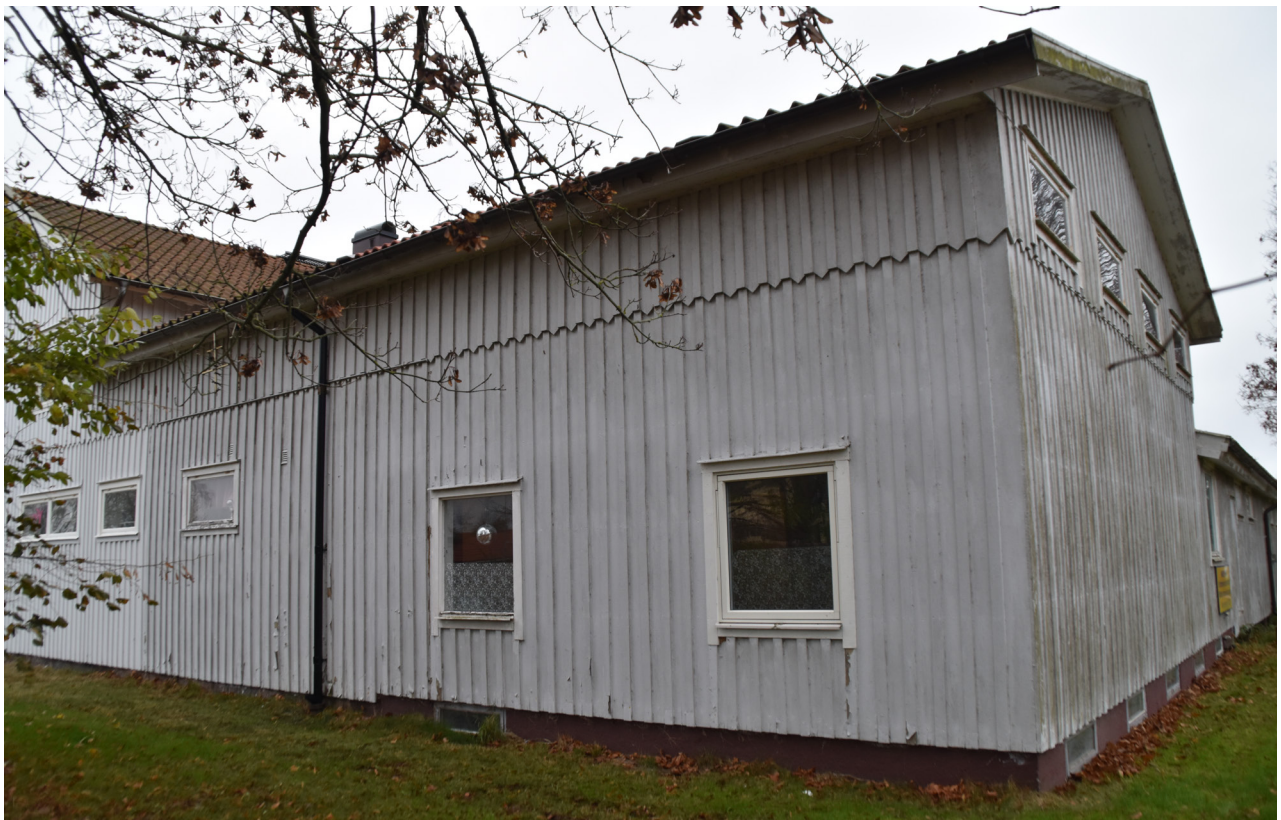
Fasad mot öster och norr. Den vänstra delen, fram till stupröret hör till den äldsta byggnaden på platsen; w magasinet längs med järnvägen. Ursprunglig stengrund finns bevarad. Under den nyare delen finns källare. Källarfönster finns i grunden. Upptill på fasaden syns den delade panelen som också markerar höjningen av huset.
