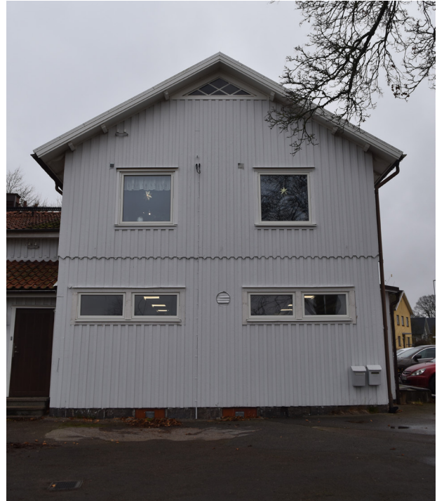
Gavlarna på tvåvåningsdelen har ungefär samma utseende med högt belägna liggande fönster nedtill, enlufts-fönster på andra våningen och ett trekantigt spröjsat fönster högst upp i gavelröstet.
