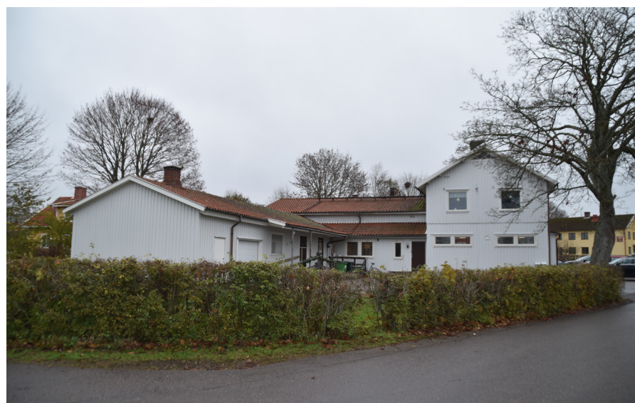
Byggnaden sedd från sydost (ovan) och väster (nedan till vänster). Hela byggnaden har locklistpanel i en ljus grå kulör och röda lertegeltak. Byggnaden omges av en trädgård med gräsmatta och träd, främst mot tomtgränsen mot öster. Grusplanen i sydost och asfaltsplanen framför byggnaden i söder används till parkering.
