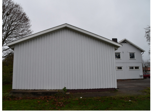
Västra fasaden på tillbyggnaden åt väster saknar idag fönster och dörrar, men eftersom det finns en trappa med vilplan har det troligen funnits en dörr tidigare.
