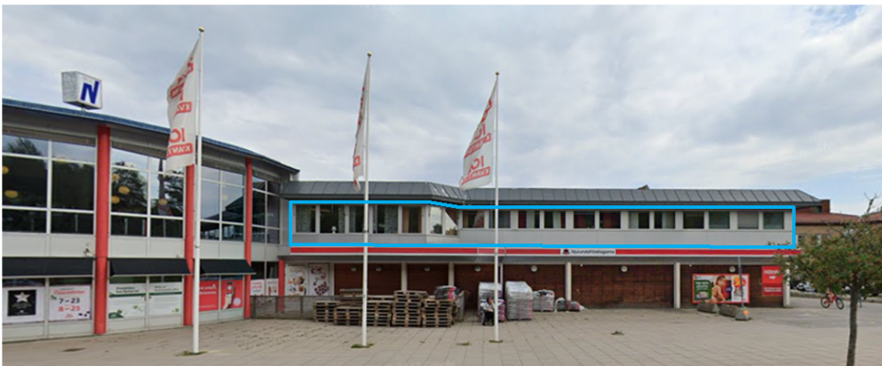
Lokalens läge i fastigheten, foto från Affärsgatan.
