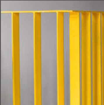
↑ Räcke i gult plattstål
