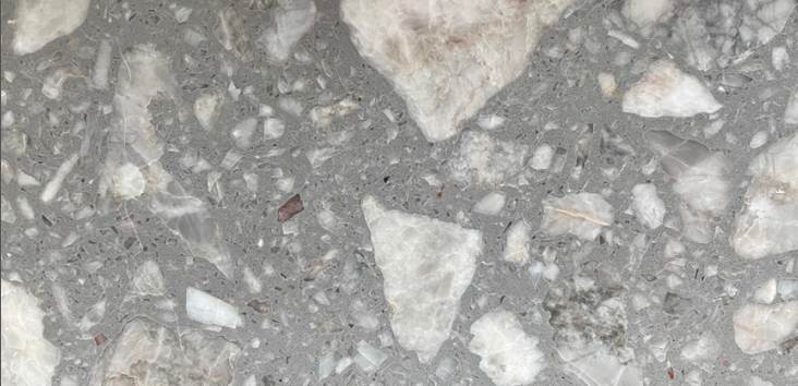
↑ Terrazzo på vägg och golv
