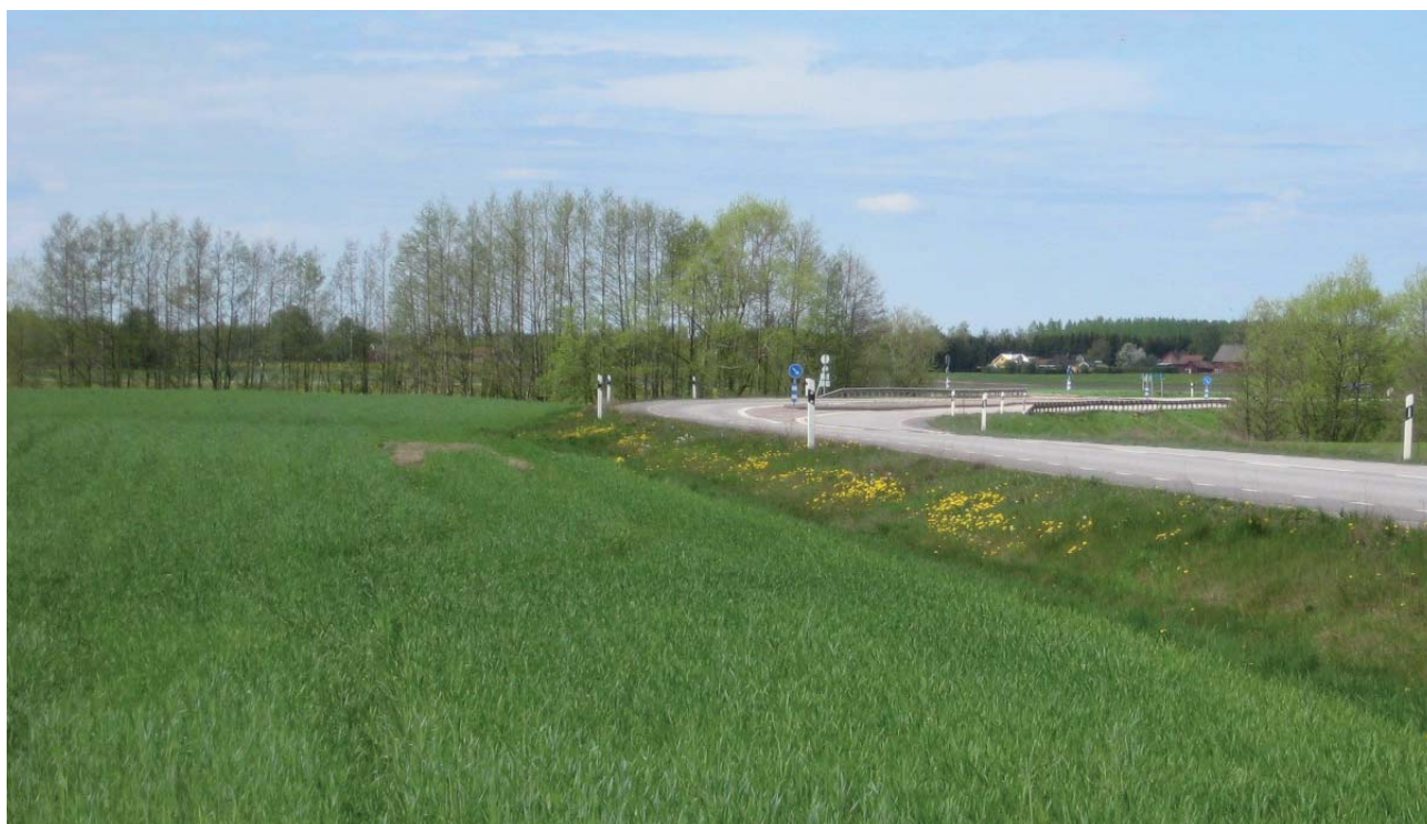
Vid passagen över Skenaån blir det två nya broar.
