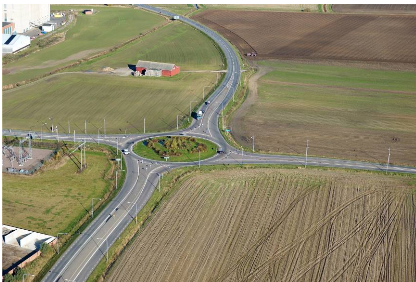
Vy över cirkulationsplatsen riksväg 32 och Linköpingsgatan – lv 206.
