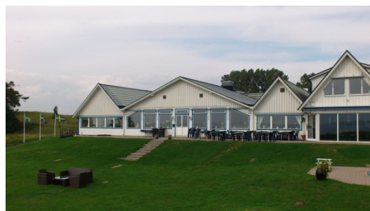
Restaurangen från söder
