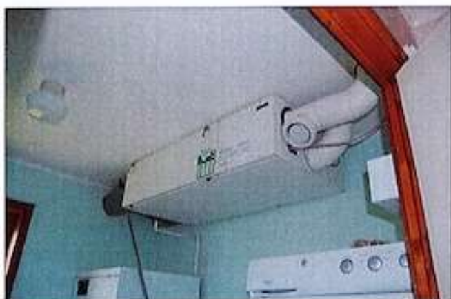
Ventilation med värmeåtervinning
