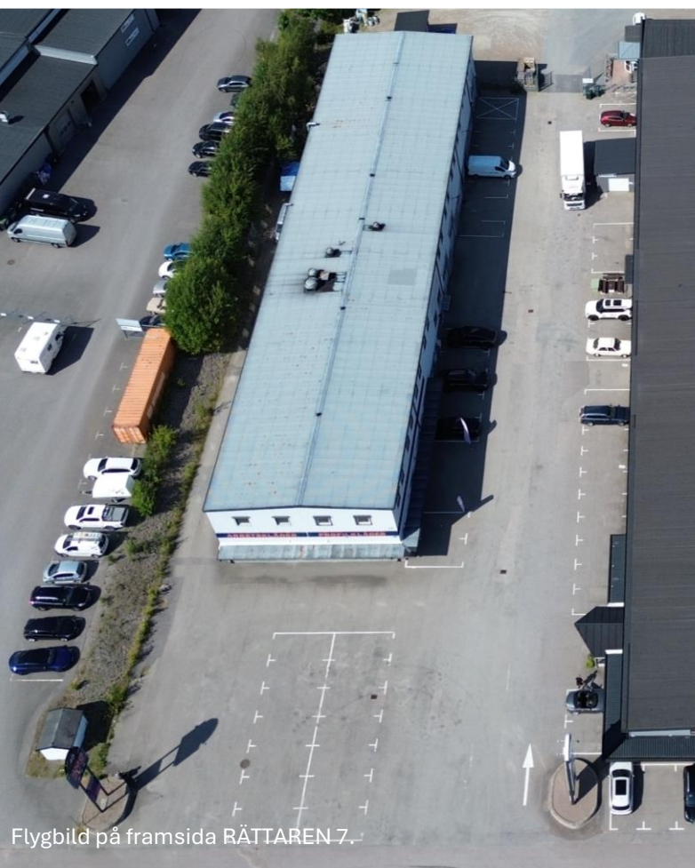
Framsida med besöksparkeringar på RÄTTAREN 7.
