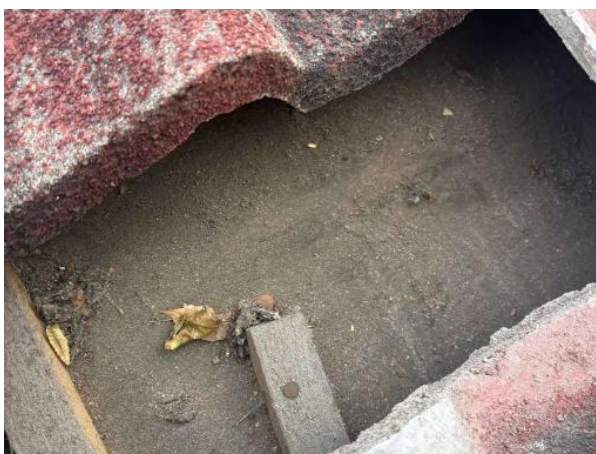
Bild 6: - Utvändigt, Yttertak, Äldre tak Otäta pannor noterades Mossa noterades på taket Fogsläpp och putssläpp finns på skorste...
