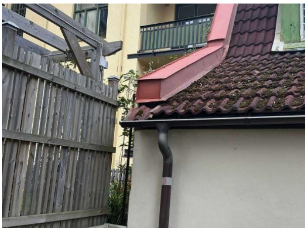
Bild 7: - Utvändigt, Yttertak, Äldre tak Otäta pannor noterades Mossa noterades på taket Fogsläpp och putssläpp finns på skorste...
