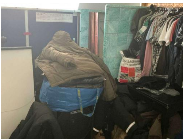
Bild 14: - Invändigt, Överväning, Äldre våtrum Används idag som förråd Gjutjärnsgolvbrunn (byt vid renovering) Delar av rummet är b...
