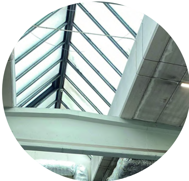
Foto bef. taklanternin och invändig balk
