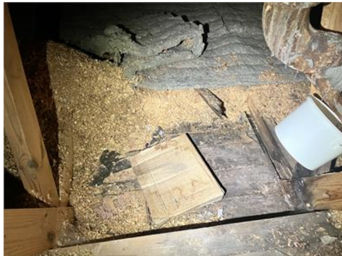
Isolering som lokalt saknas.
