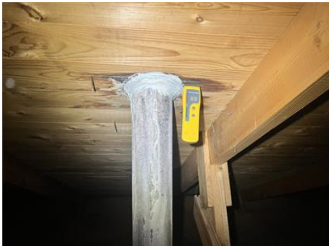
Bild från vinden. Inga förhöjda fuktvärden vid besiktningen.
