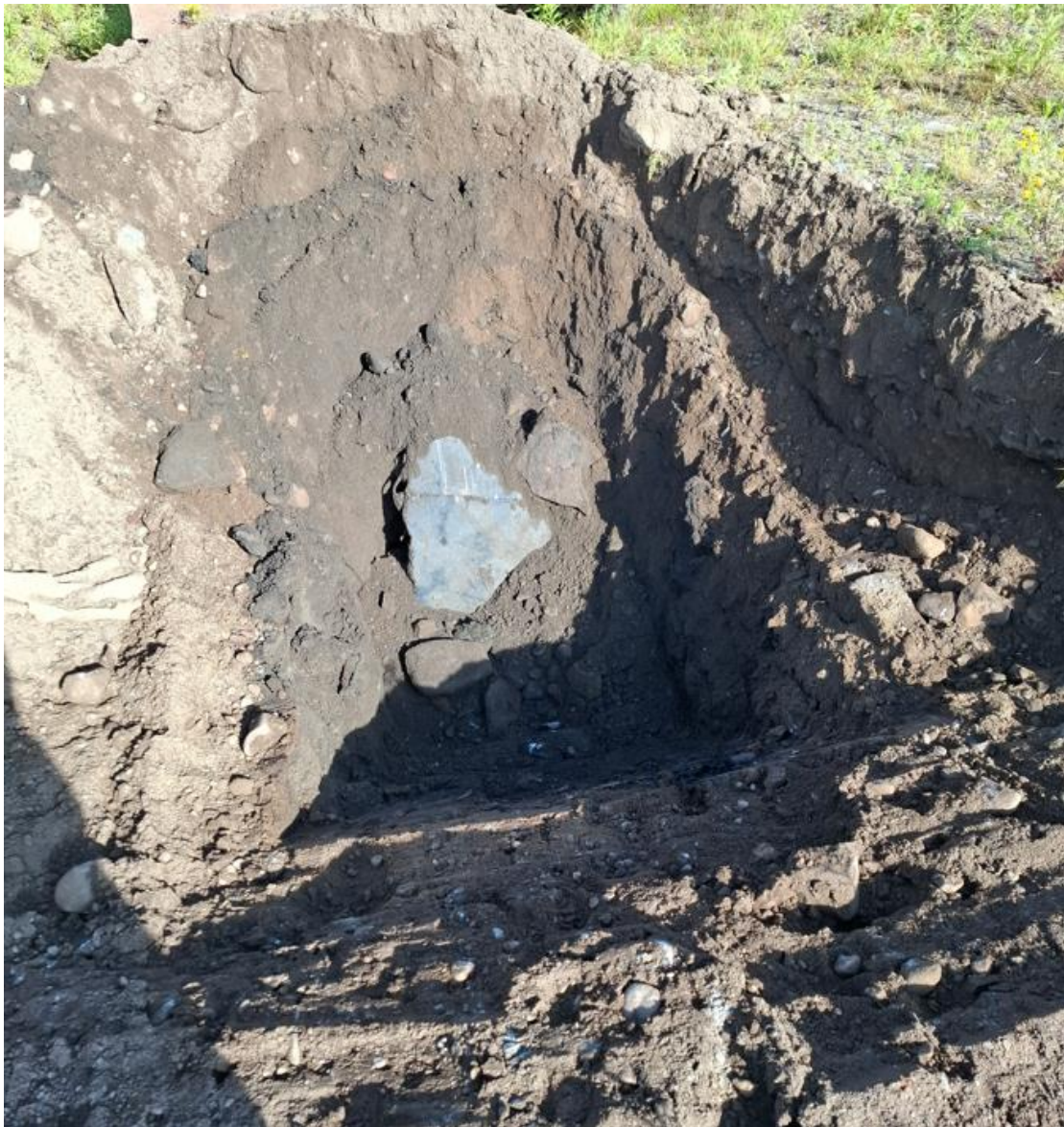
Figur 4 AV2510. Mörk fyll med sand, sten, betong och tegel till 3,4 m.
