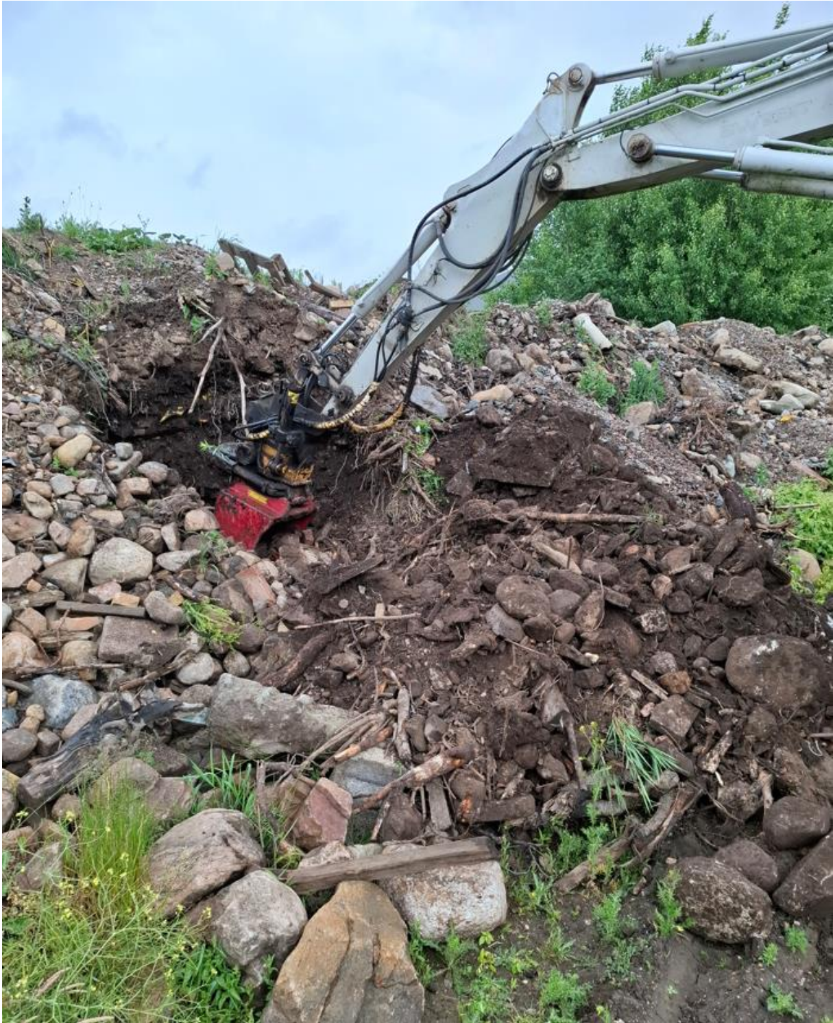
Figur 8 AV2505. Grävning i vallen. Trä, sten mm.
