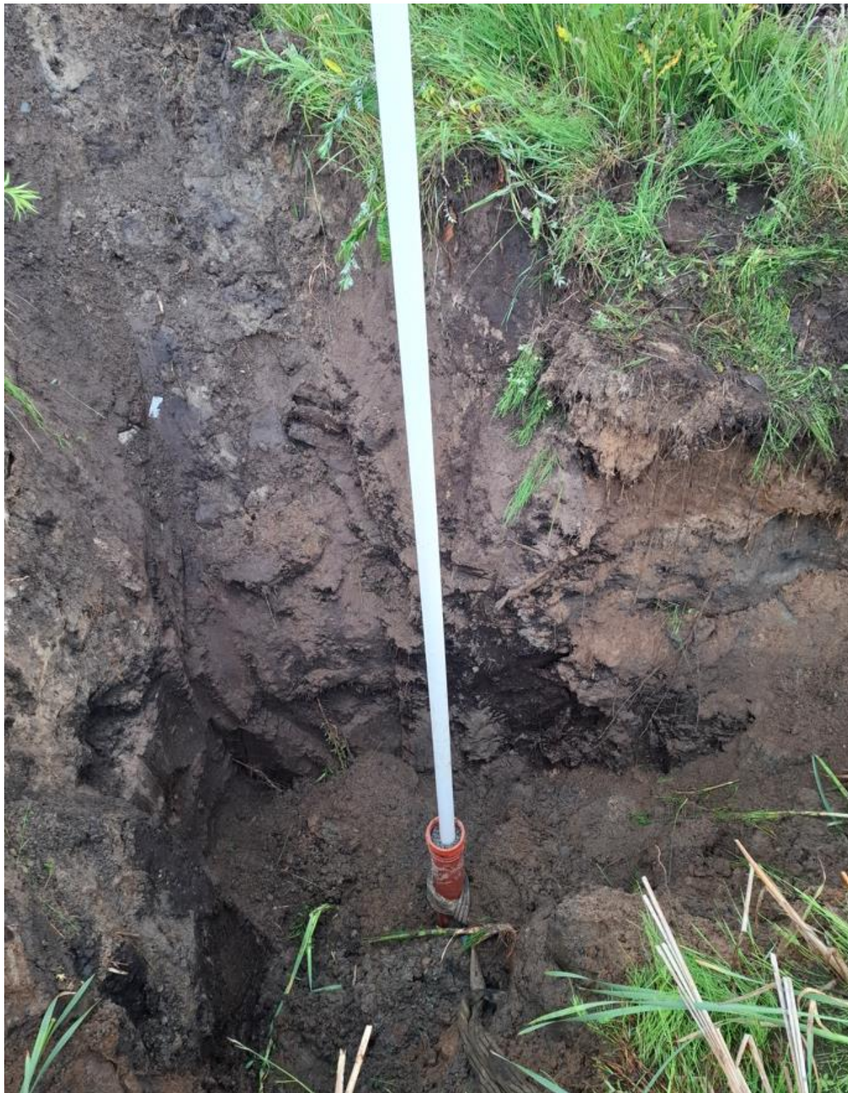
Figur 2. Installation av grundvattenrör i AV2502.
