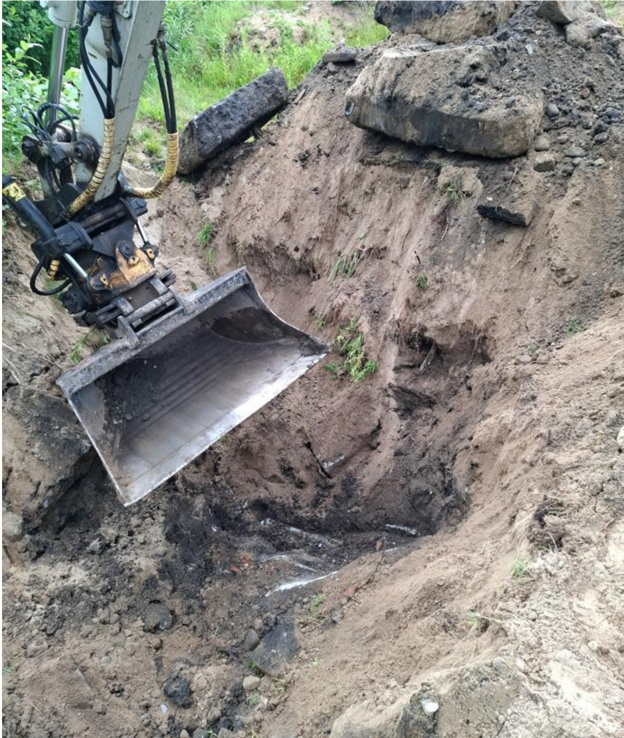
Figur 5 AV2501. Sand över mörk fyll med betong.
