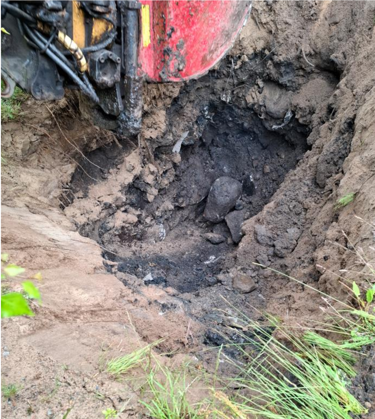
Figur 7 AV2503. Svart, sotigt fyll med sten och betongblock.
