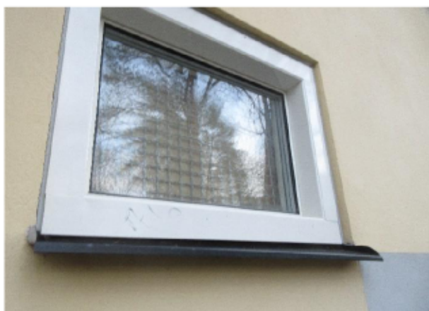
Nya fönster monterade
