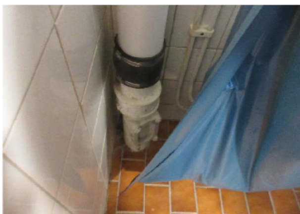
Gamla avloppsrör under betongplattan
