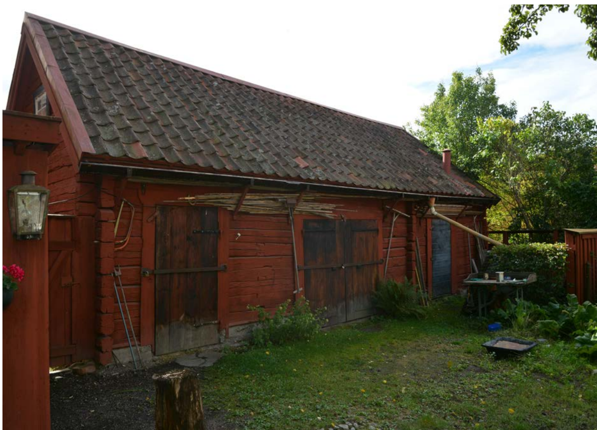
Bild 150. Uthuset, hus 3 ligger beläget i tomtgräns och har bevarat sin ålderdomliga karaktär (SLM D2017-0135).
