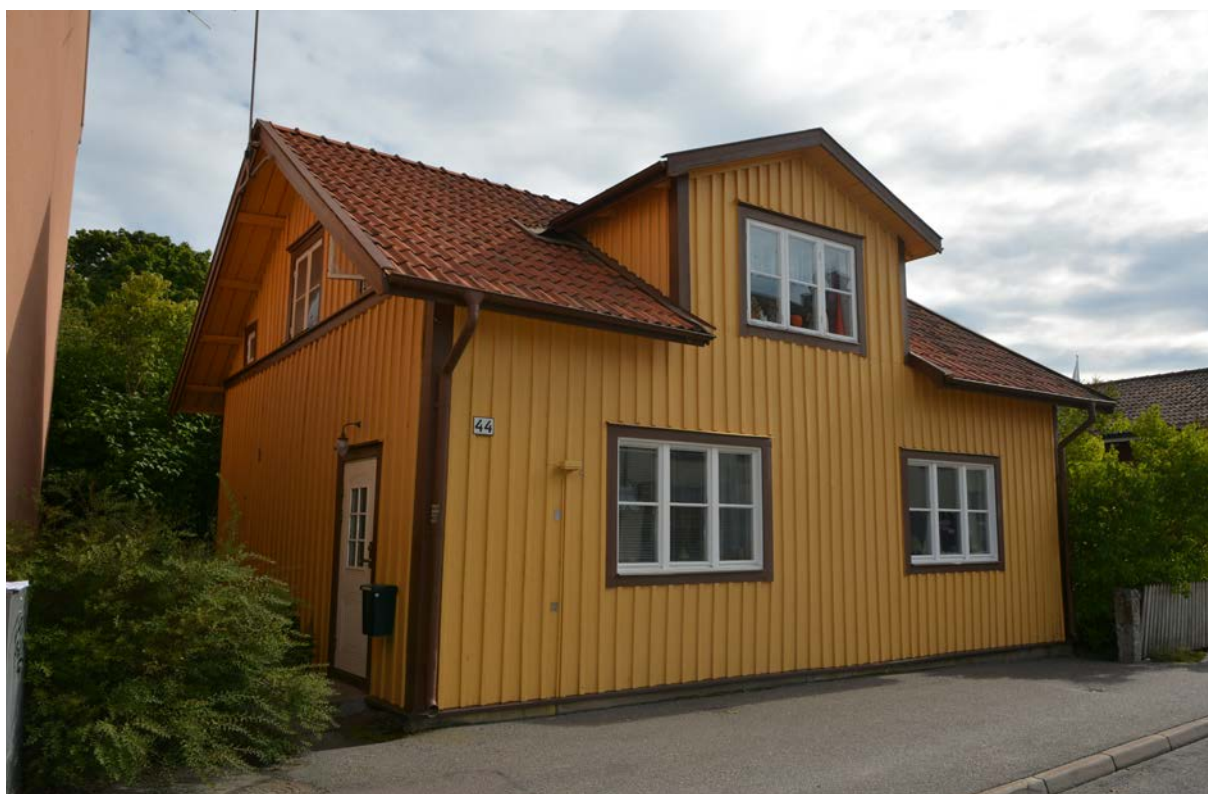
Bild 165. Entrén är belägen på sydvästra gaveln (SLM D2017-0150).
