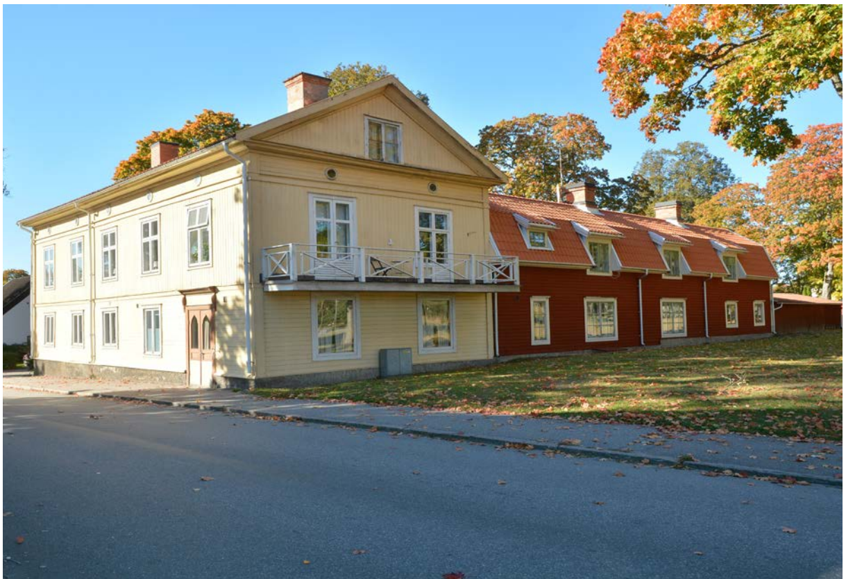
Bild 25. Kvarteret Apotekaren hösten 2016. Huvudbyggand med liggande och stående gul panel (hus 1) ligger utmed Tingsgatan som vätter mot Gustaf Adolf torg (SLM D2017-0027).
