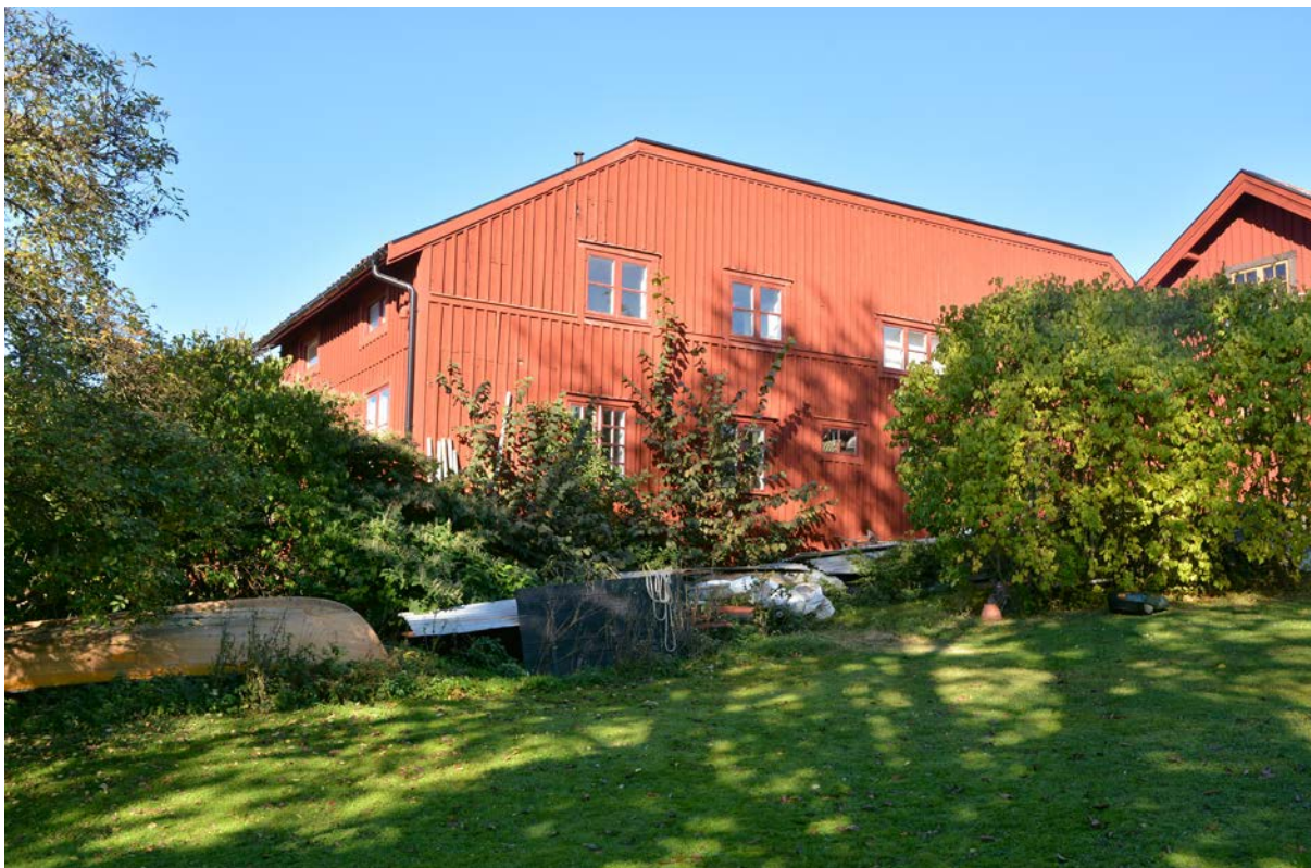
Bild 182. Gårdshuset sett från grannfastigheten (SLM D2017-0162).
