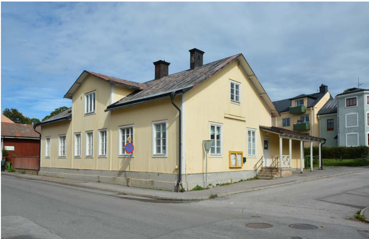
Bild 152. "Läkarvillan" sedd från Landsvägsgatan, södra långsidan västra gaveln (SLM D2017-0137).
