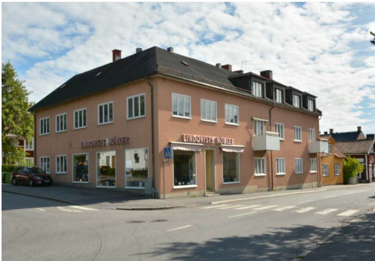
Bild 156. Vinkelbyggnaden är belägen i hörnet Tingsgatan/Landsvägsgatan (SLM D2017-0141).
