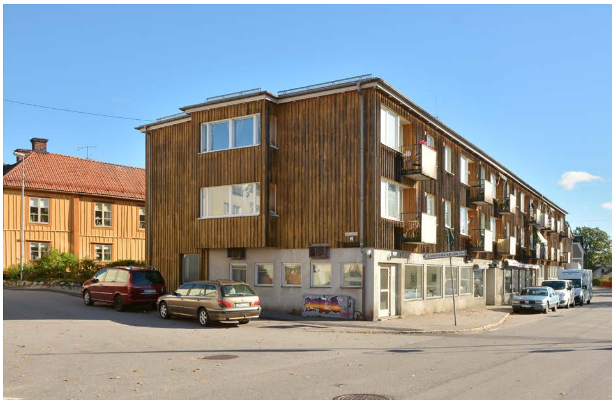
Bild 69. Västra gaveln och södra fasaden, väster i bild skymtar Gula Knuten (SLM D2017-0066).
