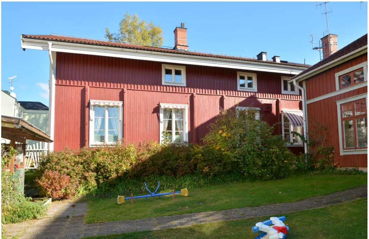
Bild 77. Södra fasaden sedd från grannfastigheten (SLM D2017-0074).
