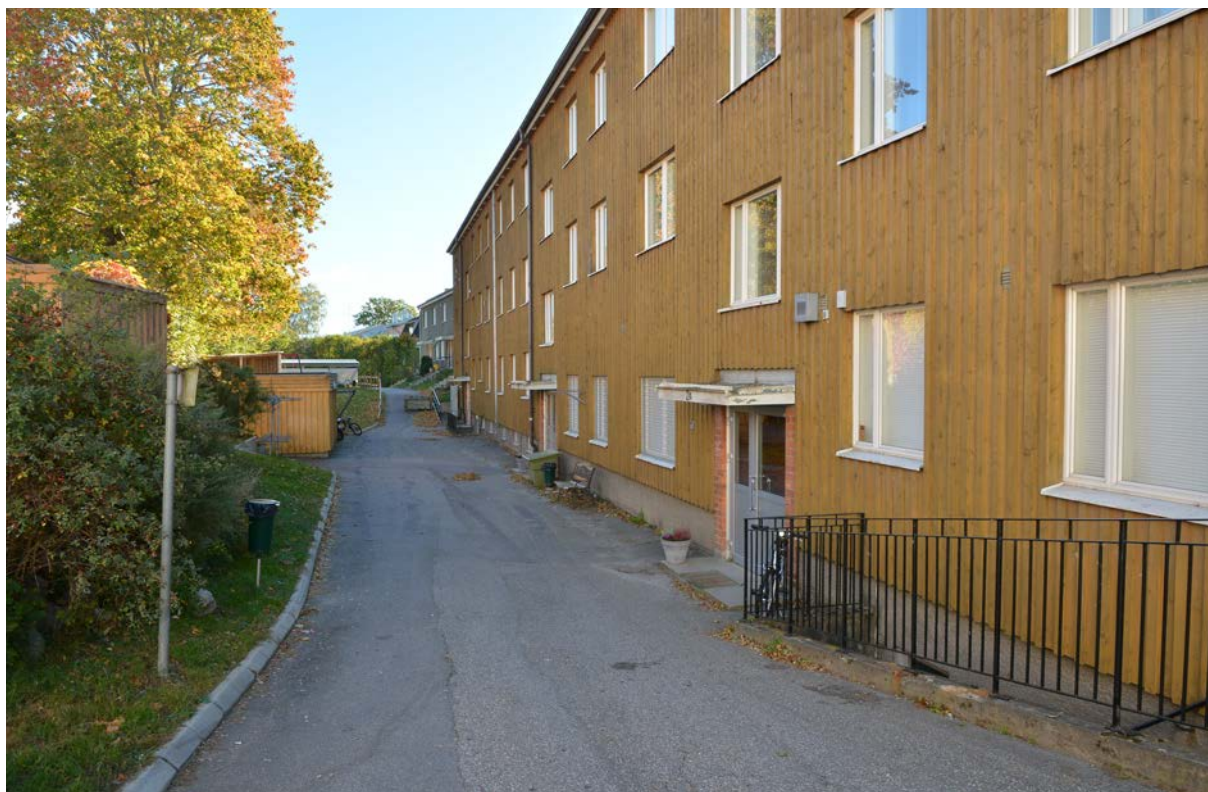
Bild 71. Gårdsfasaden har en enklare utformning (SLM D2017-0068).
