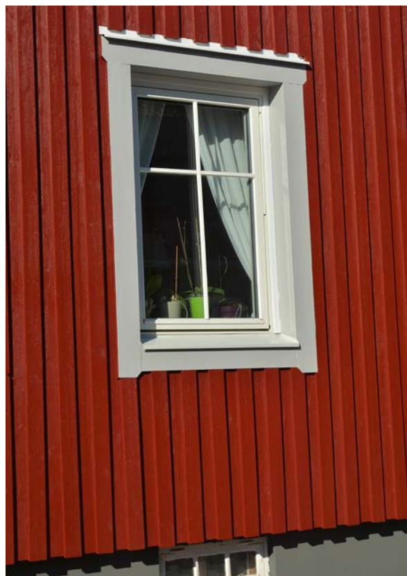
Bild 19. Utbytt fönster och tilläggsisolerad fasad (SLM D2017-0023).
