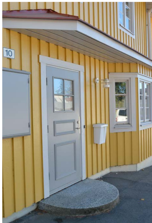
Bild 73. Detalj av entréparti (SLM D2017-0070).
