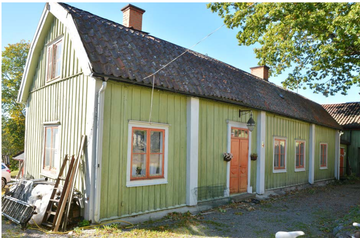
Bild 183. Huvudbyggnadens norra fasad (SLM D2017-0163).
