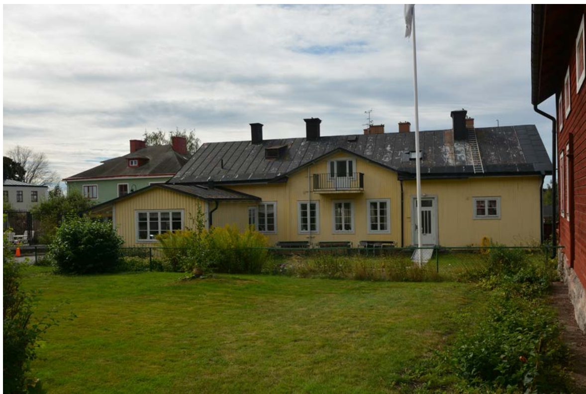
Bild 155. Norra fasaden sedd från gården (SLM D2017-0140).
