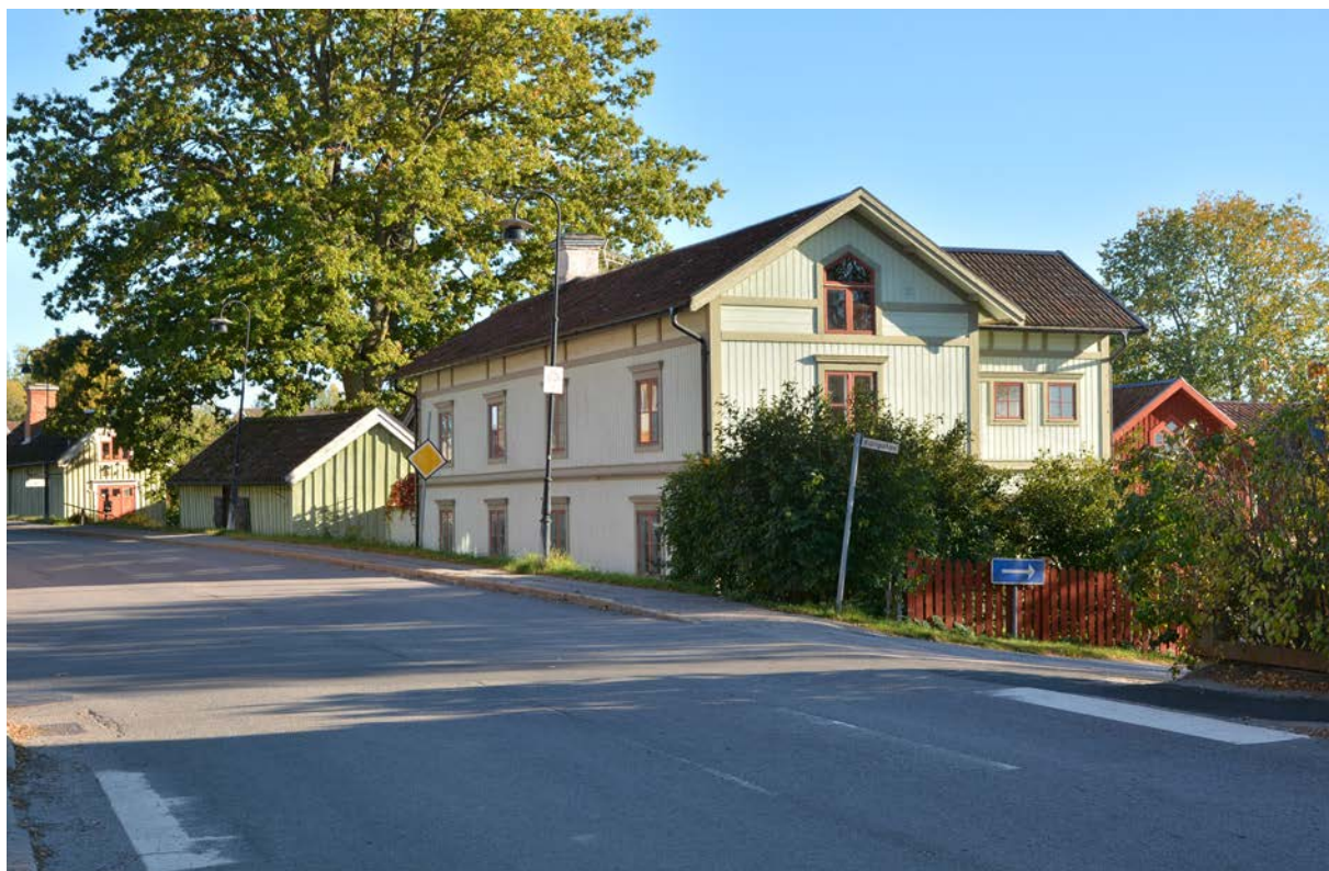
Bild 175. Norra fasaden är belägen utmed Landsvägsgatan (SLM D2017-0155).
