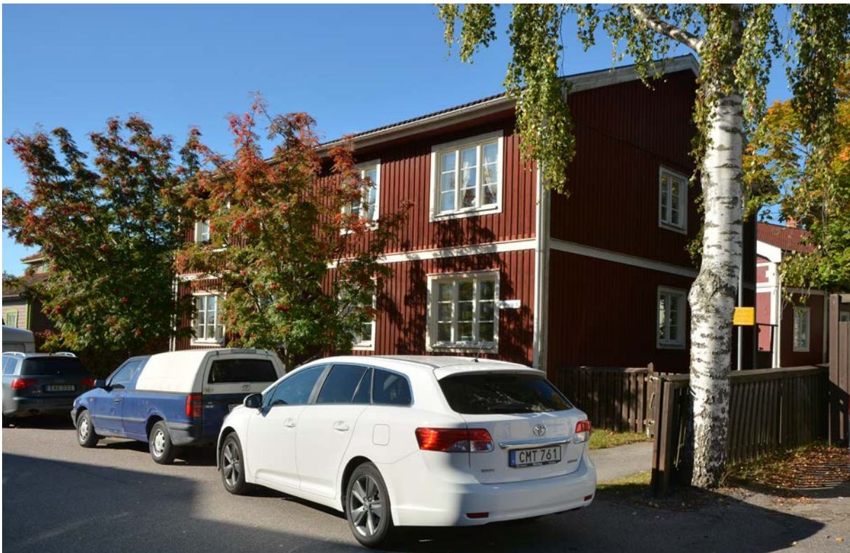
Bild 78. Östra fasaden mot Badhusgatan (SLM D2017-0075).
