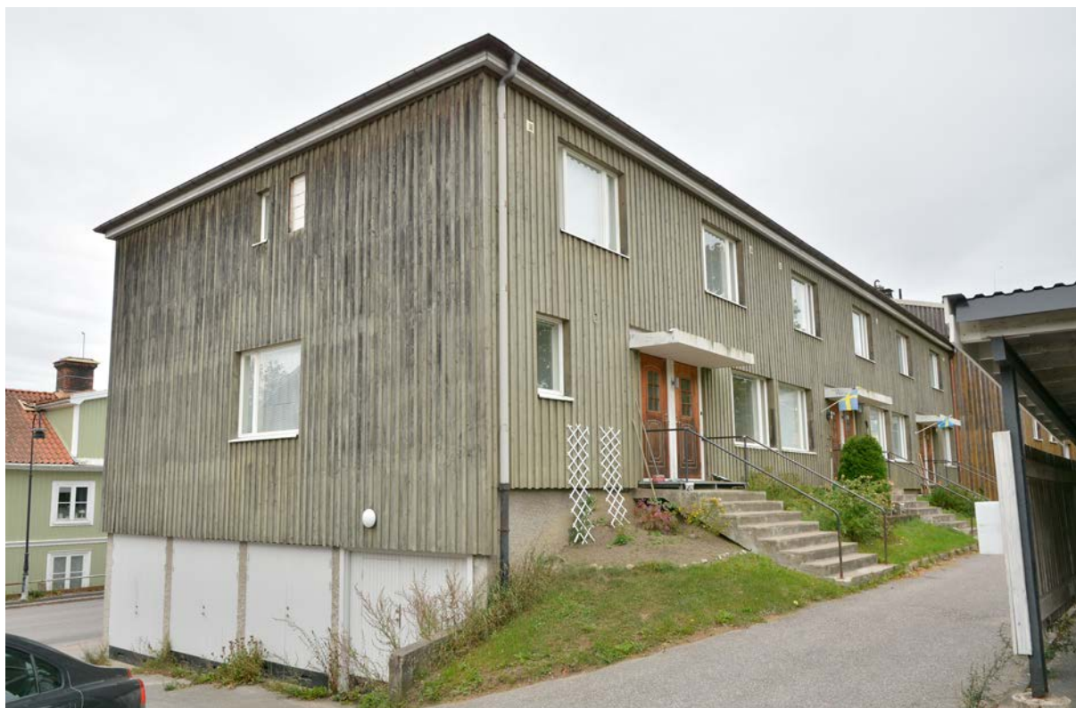
Bild 68. Norra fasaden (SLM D2017-0065).
