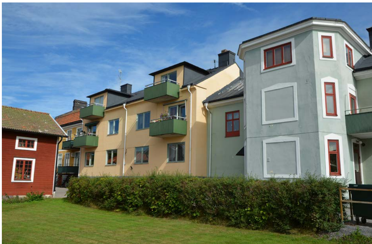
Bild 162. Hus 9 A och B sett från gårdsidan (SLM D2017-0147).
