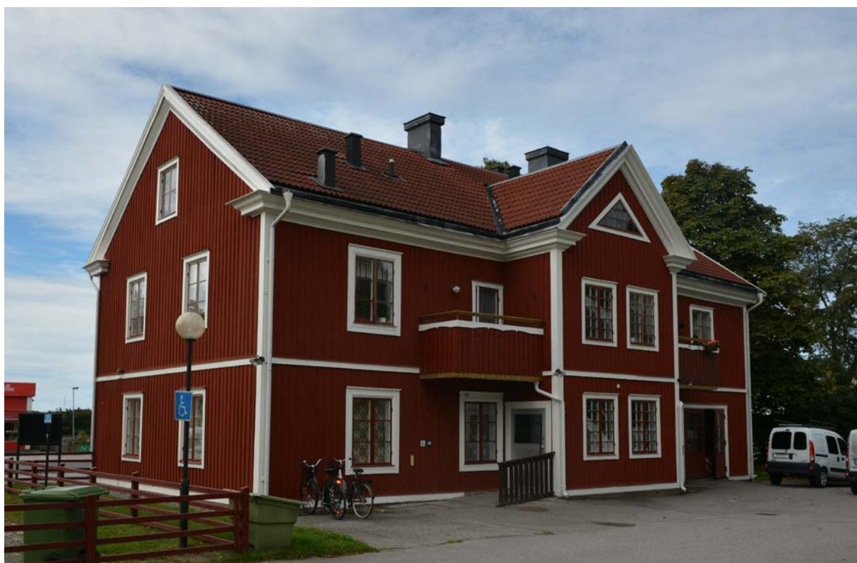
Bild 125. Norra fasaden (SLM D2017-0113).
