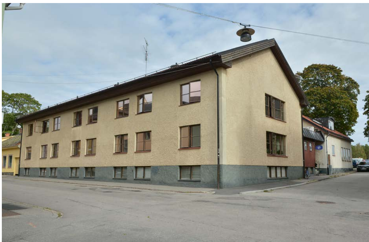
Bild 113. Vårdhemmets huvudbyggnad sedd från Storgatan i hörnet av Köpmangatan (SLM D2017-0104).
