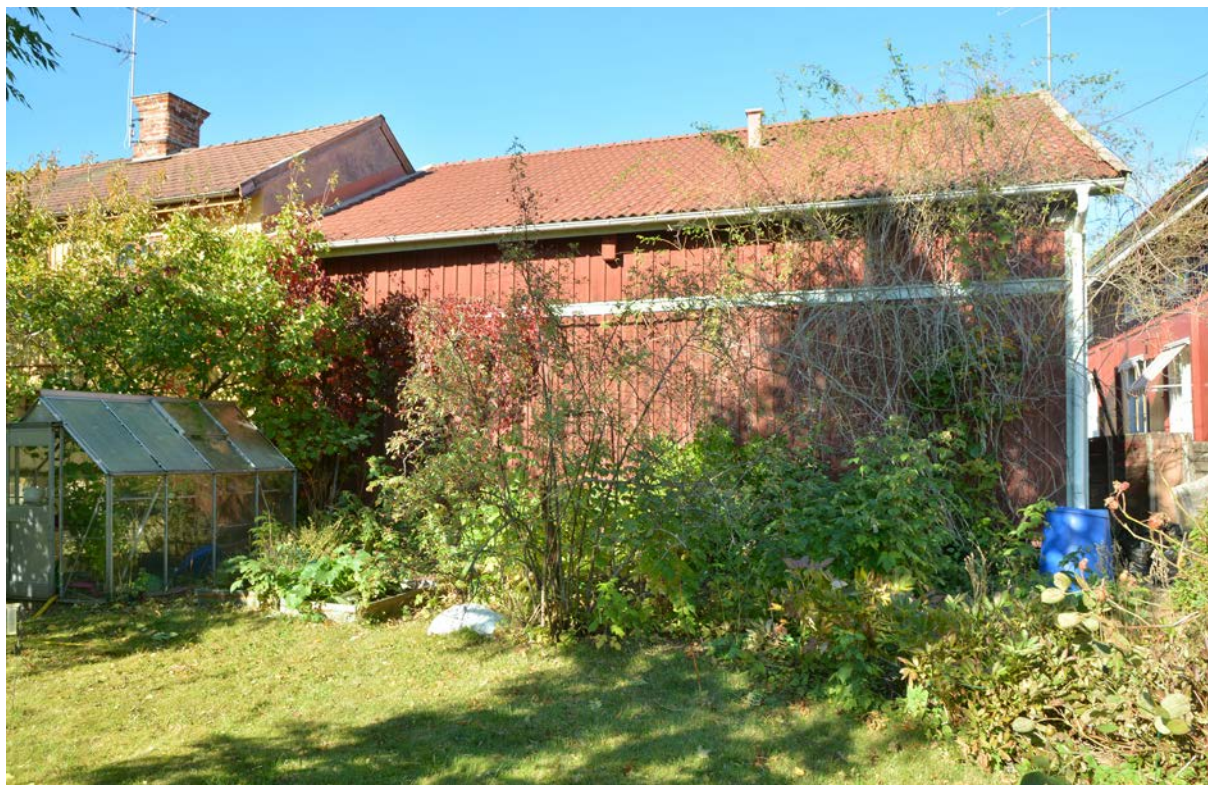
Bild 95. Baksidan sedd från tomt 9. Till höger i bild skymtar Färgaren 15 (SLM D2017-0092).
