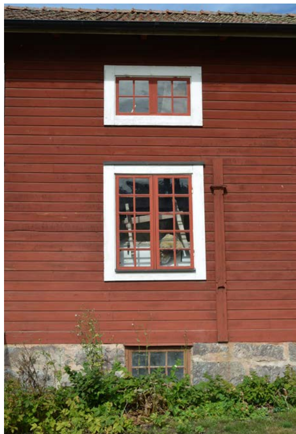
Bild 140. Detalj av fönster och naturstenssockel hus 3. (SLM D2017-0125).
