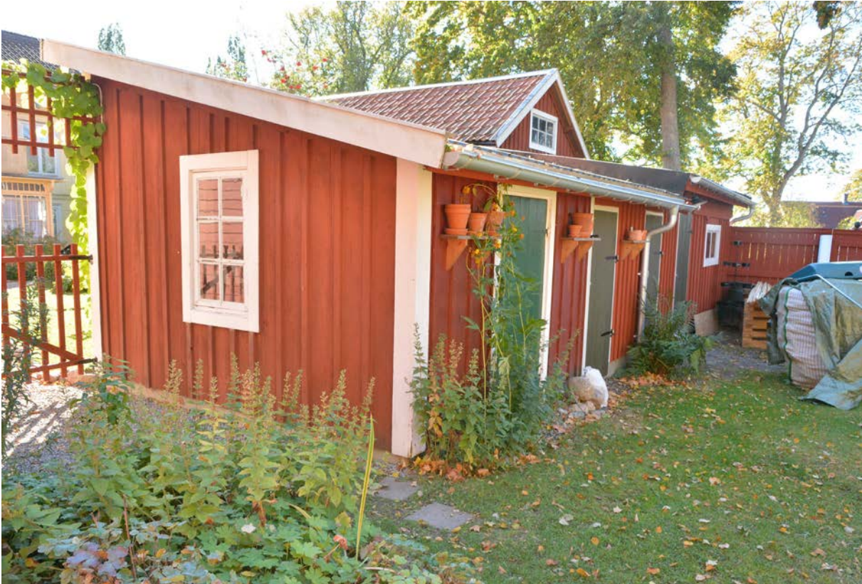
Bild 36. Hus 4 västra gaveln och östra fasaden (SLM D2017-0038).
