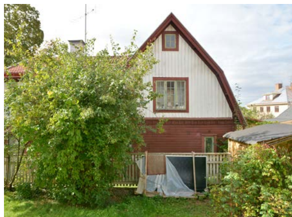
Bild 51-52. Detalj av grinden samt norra gaveln. (SLM D2017-0051-0052)
