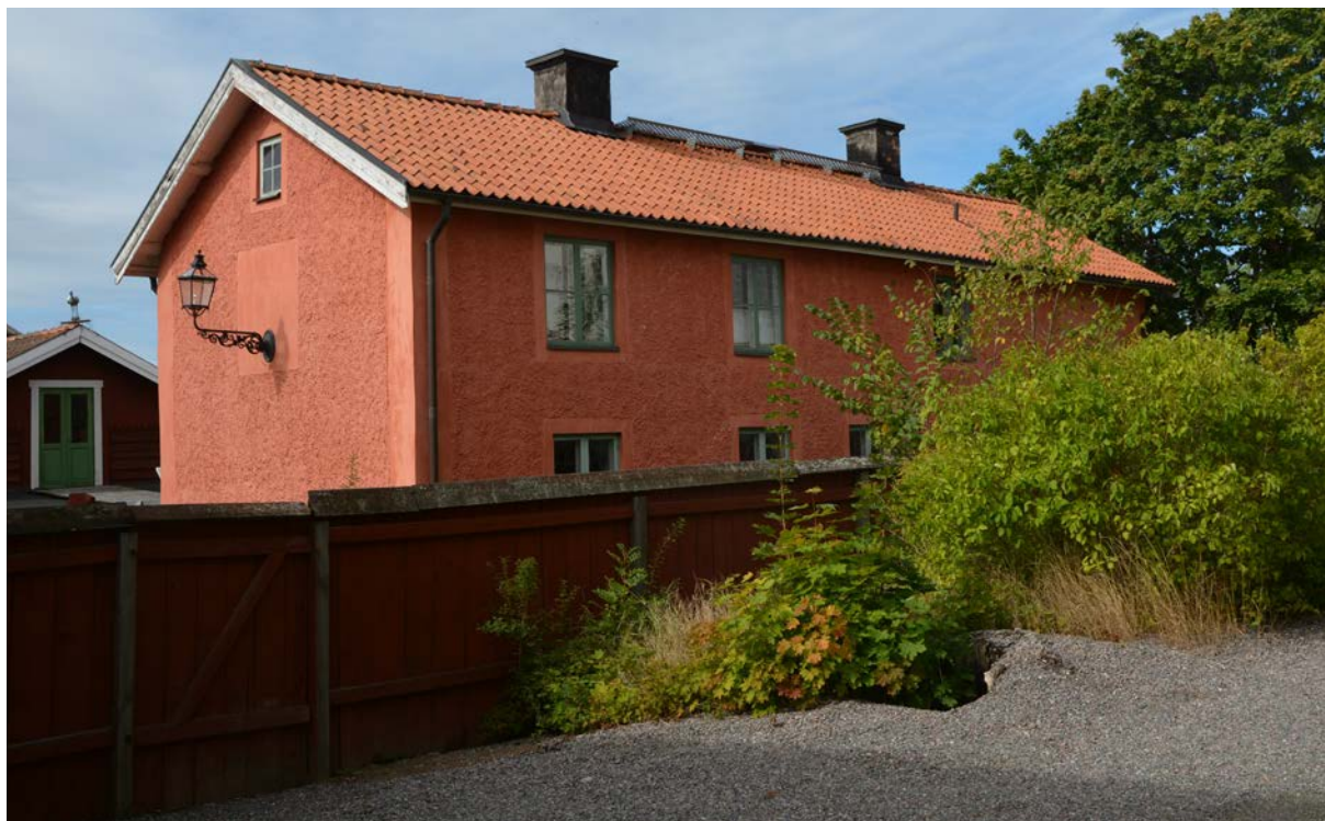
Bild 137. Norra fasaden. Gården omgärdas av rött plank (SLM D2017-0122).
