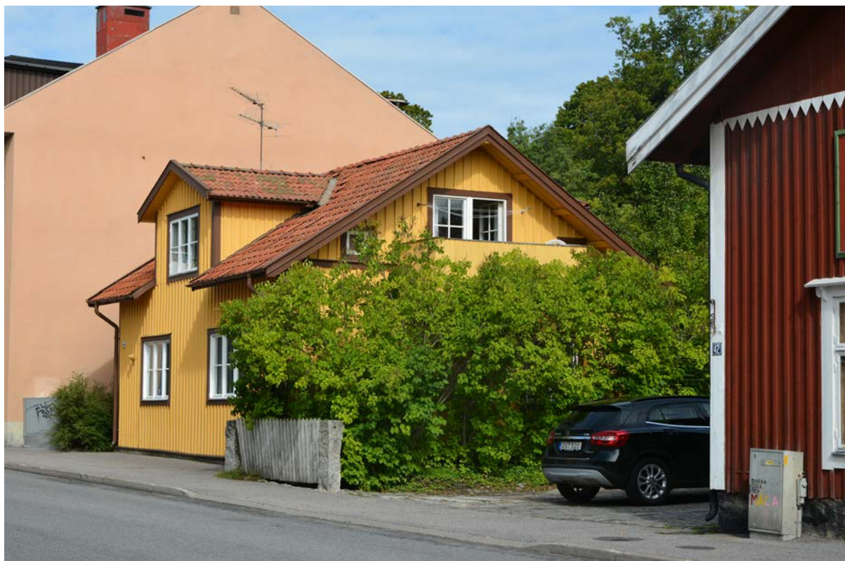
Bild 163. Byggnaden ligger i direkt anslutning till gatan utan förgårdsmark (SLM D2017-0148).
