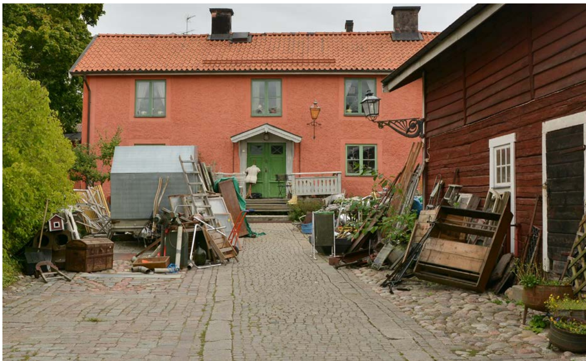
Bild 135. Huvudbyggnadens södra fasad. Till höger i bild ses ekonomibyggnaden (hus två) (SLM D2017-0120).
