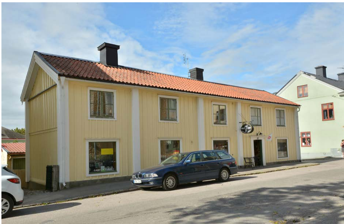
Bild 42. Norra fasaden, byggnaden är ett av de äldsta husen i Malmköping enligt äldre kartor (SLM D2017-0042).
