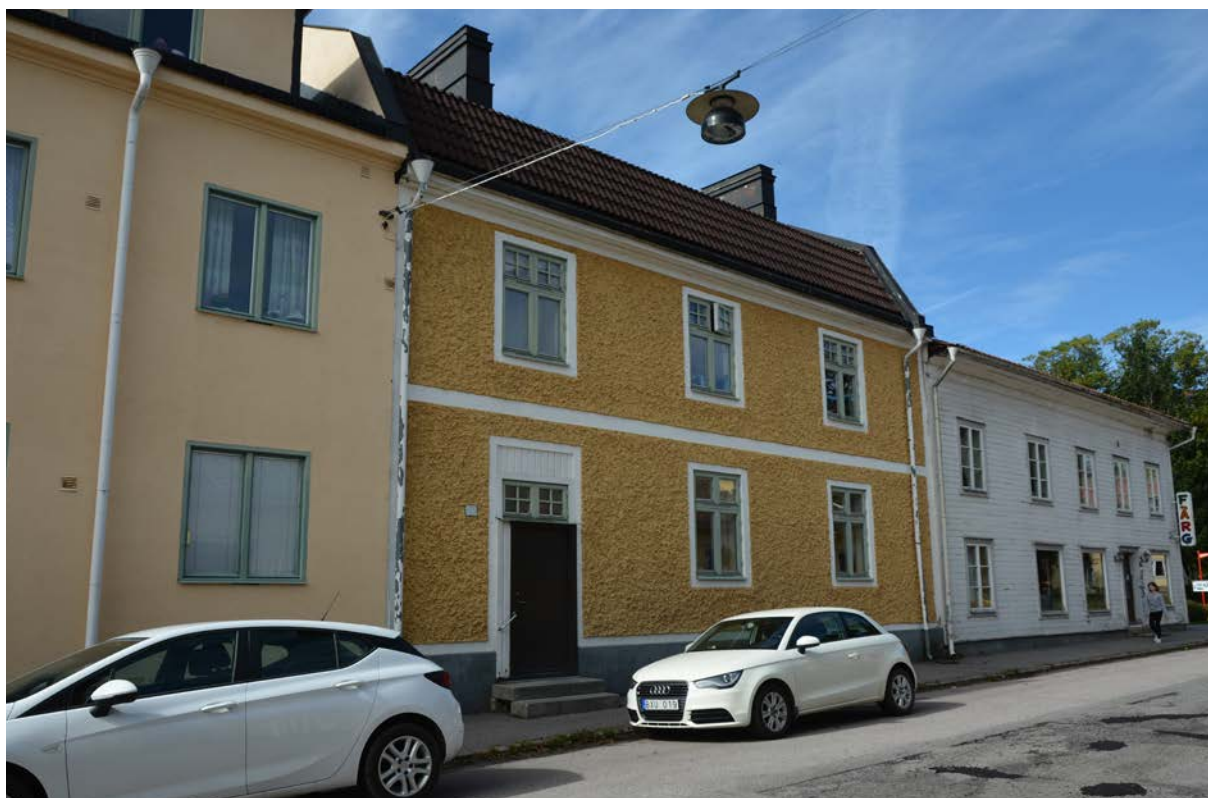
Bild 132. Fasaden har den för Malmköping särpräglade spritputsen (SLM D2017-0117).
