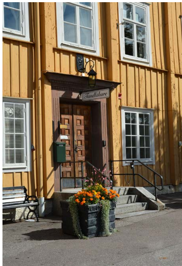
Bild 215. Detalj av entréparti (SLM D2017-0191).
