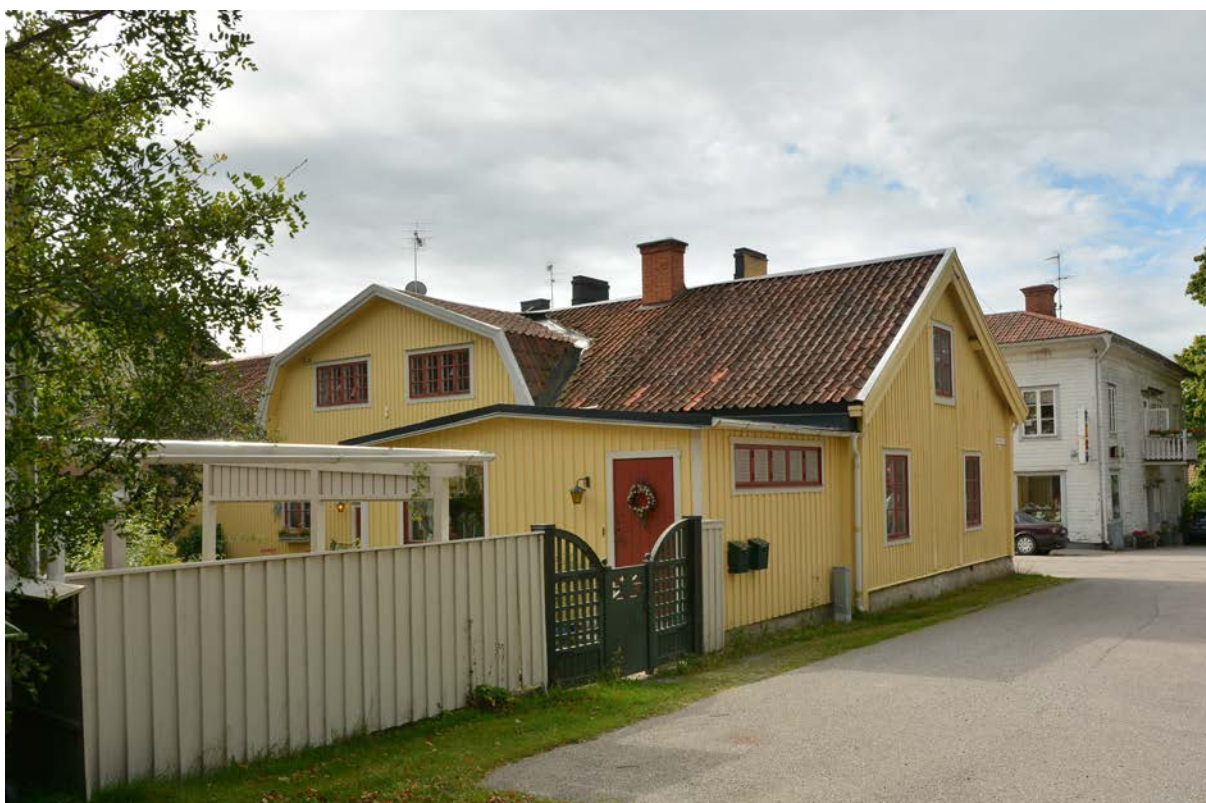
Bild 108. Norra fasaden (SLM D2017-0099).
