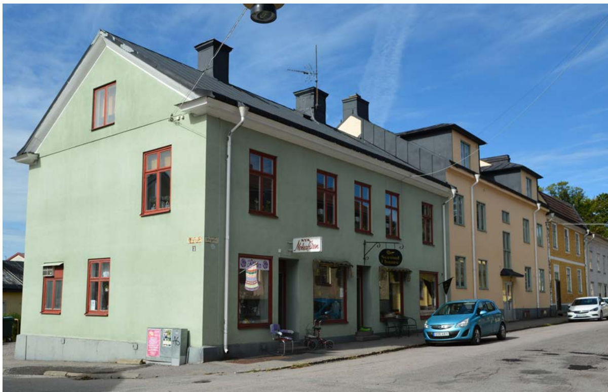
Bild 159. Närmast i bild bostads- och affärshus från 1880-talet. Näst intill flerbamiljshus från 1939 (SLM D2017-0144).
