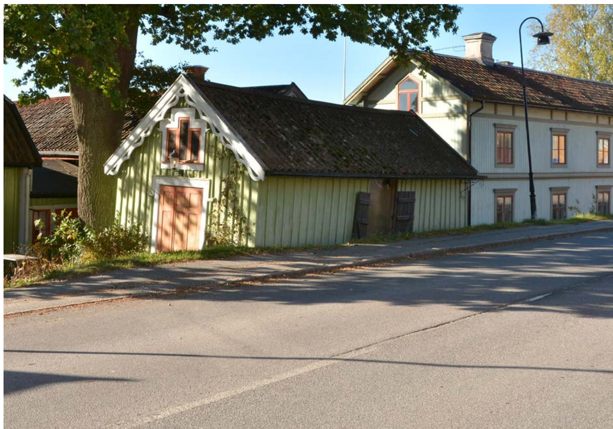
Bild 187. Nordvästra flygeln sett från Landsvägsgatan (SLM D2017-0170).
