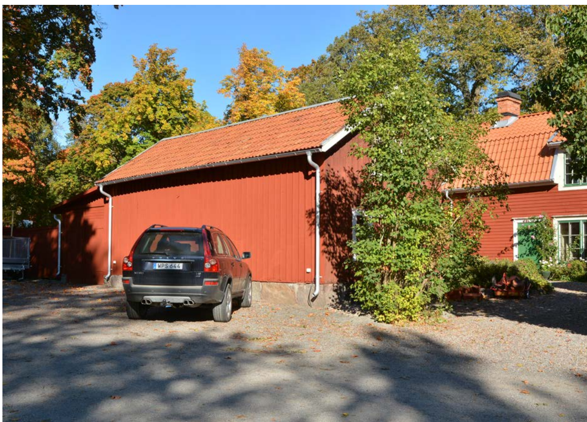
Bild 35. Hus 3 ligger i anslutning till Storgatan (SLM D2017-0037).
