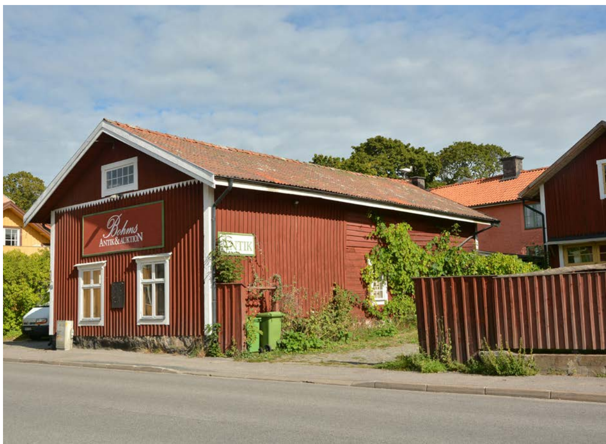
Bild 143. Hus 2 sett från Landsvägsgatan till höger i bild skymtar hus 4 (SLM D2017-0128).
