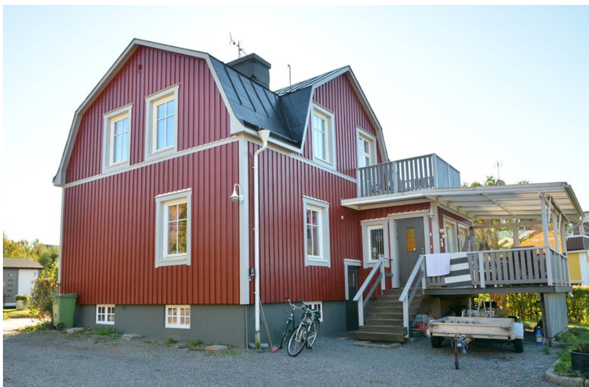
Bild 202. Entrén är placerad mot gården (SLM D2017-0182).
