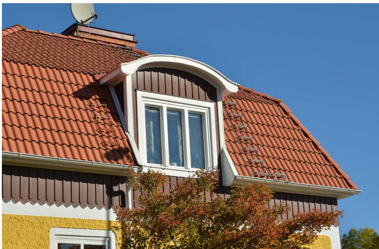
Bild 199. Detalj av takkupan som samverkar med entrétaket (SLM D2017-0179).
