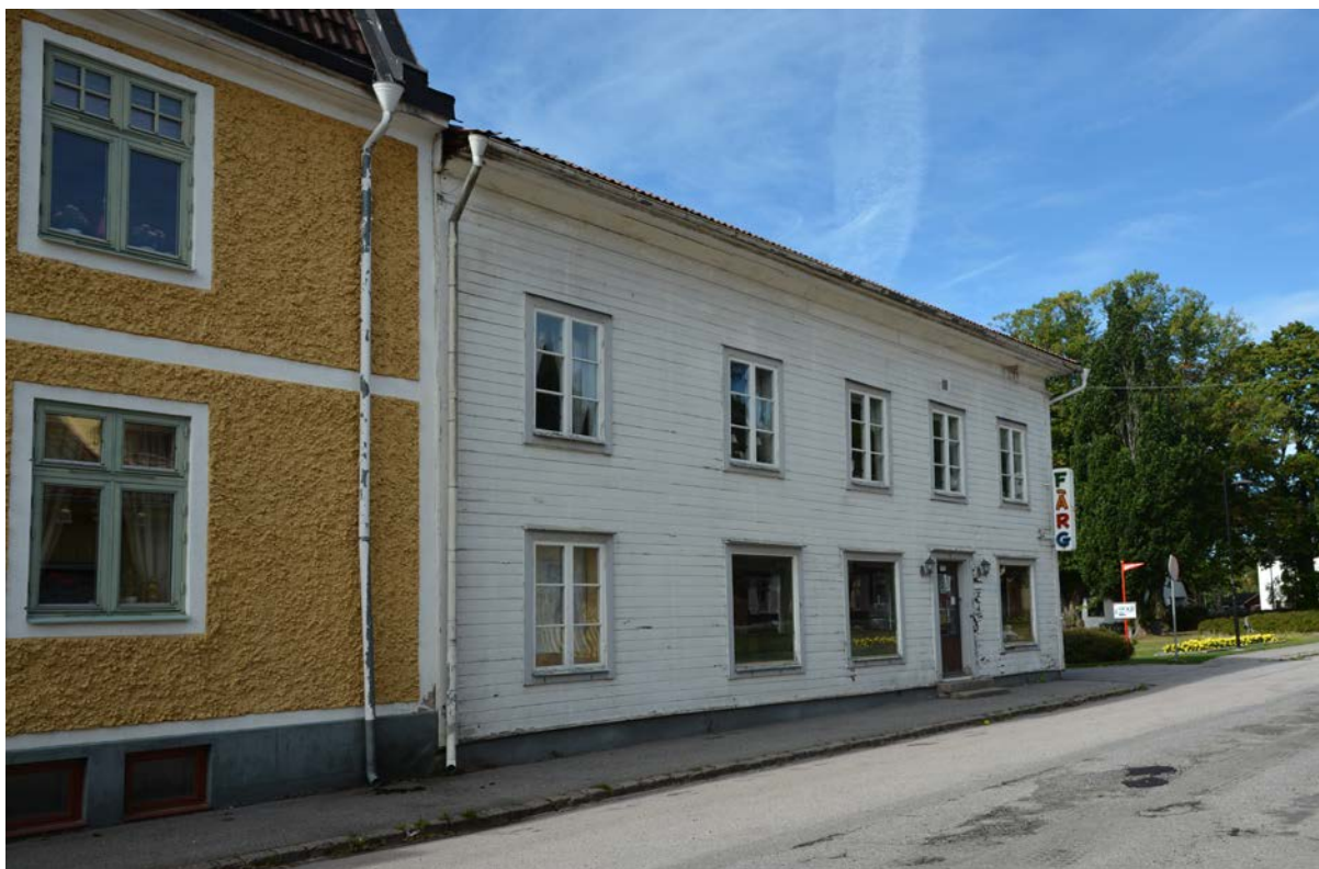
Bild 131. Byggnaden sedd från Storgatan (SLM D2017-0116).
