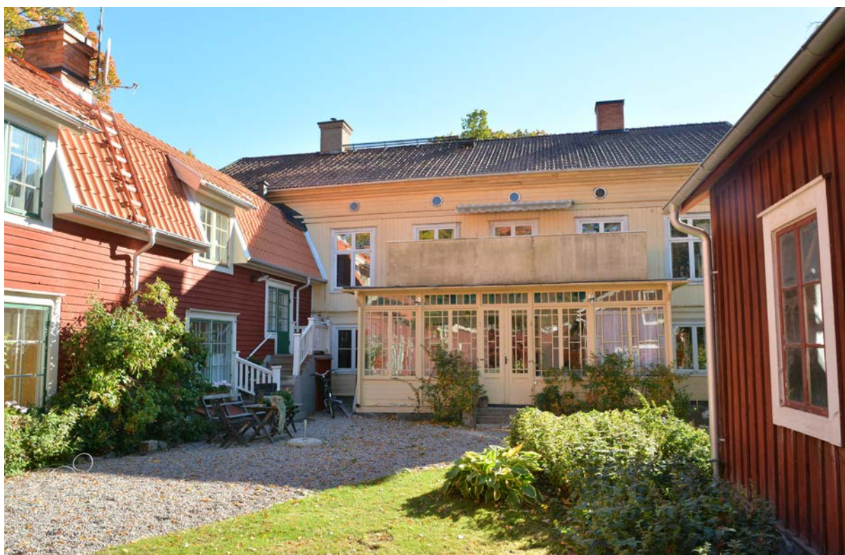
Bild 28. Kringbyggd gård i mitten av Apotekaren 1, västra fasaden med glasveranda (SLM D2017-0030).
