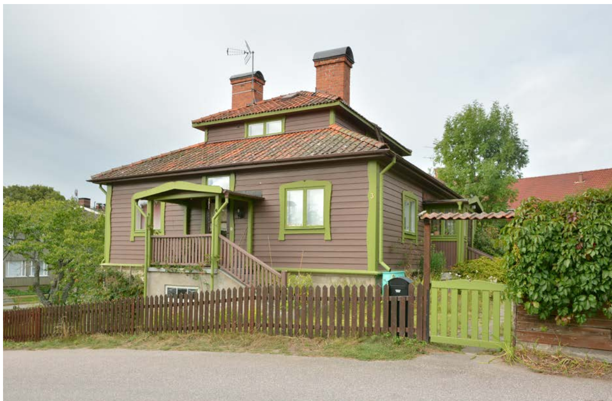
Bild 60. Östra- och norra fasaden (SLM D2017-0057).
