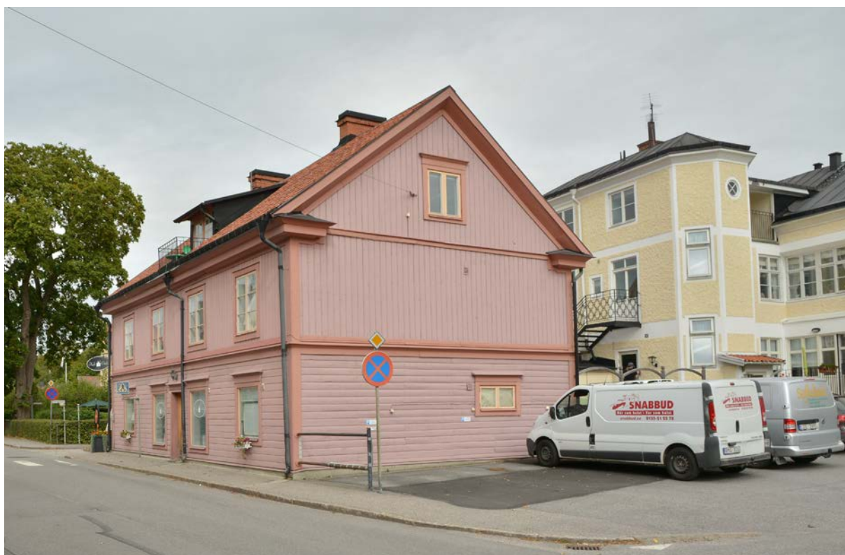
Bild 138. Södra fasaden och östra gaveln. I bakgrunden skymtar hus 2 (SLM D2017-0205).
