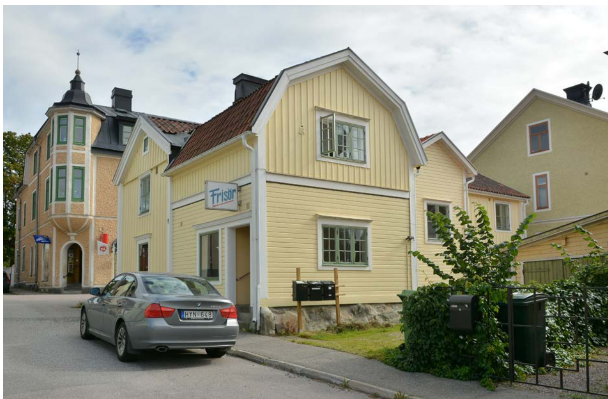
Bild 45. Byggnaden sedd från Köpmannagatan, tillbyggnaden från 1940-talet närmast i bild (SLM D2017-0045).
