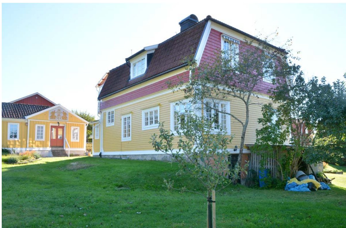
Bild 193. Norra fasaden och östra gaveln, i bakgrunden skymtar hus 2 (SLM D2017-0173).
