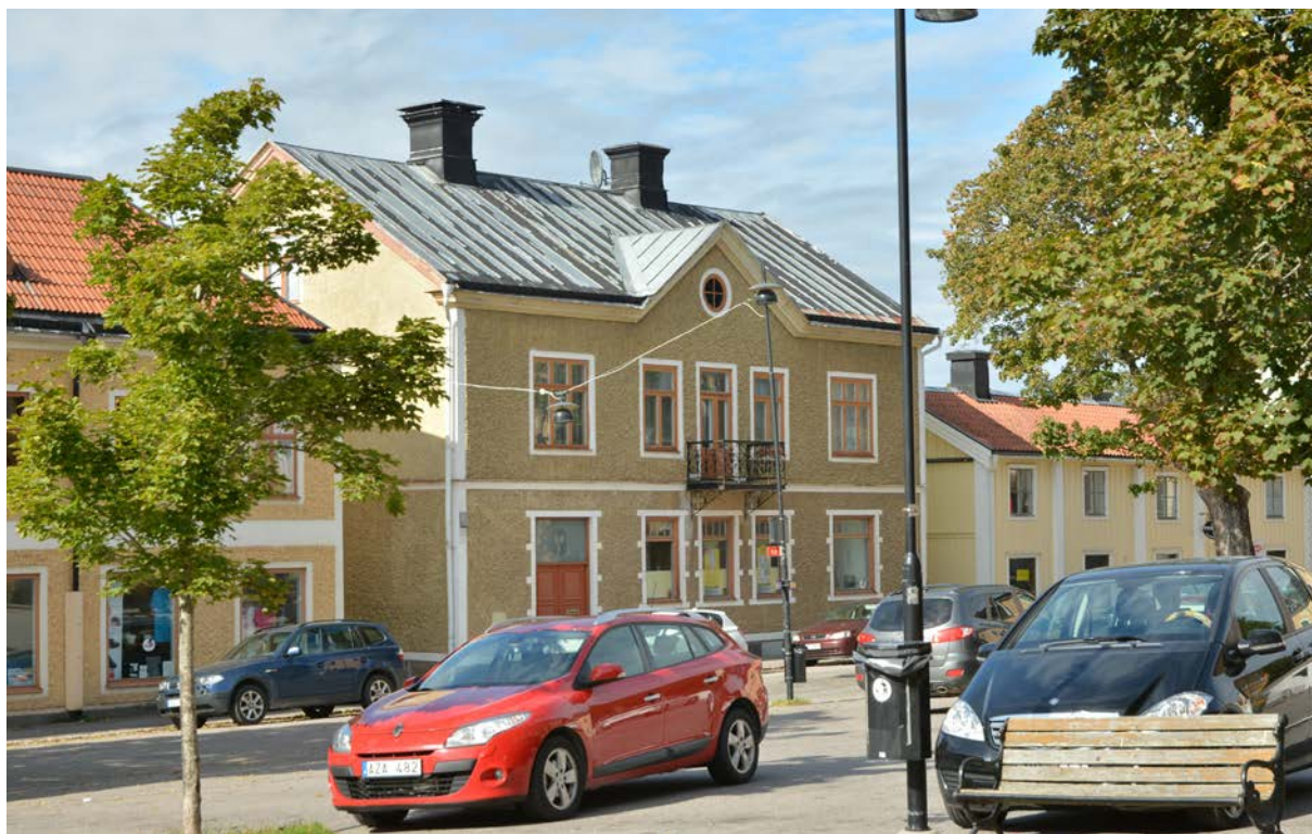
Bild. 46. Västra fasaden ligger vänd mot Storgatan och torget (SLM D2017-0046).
