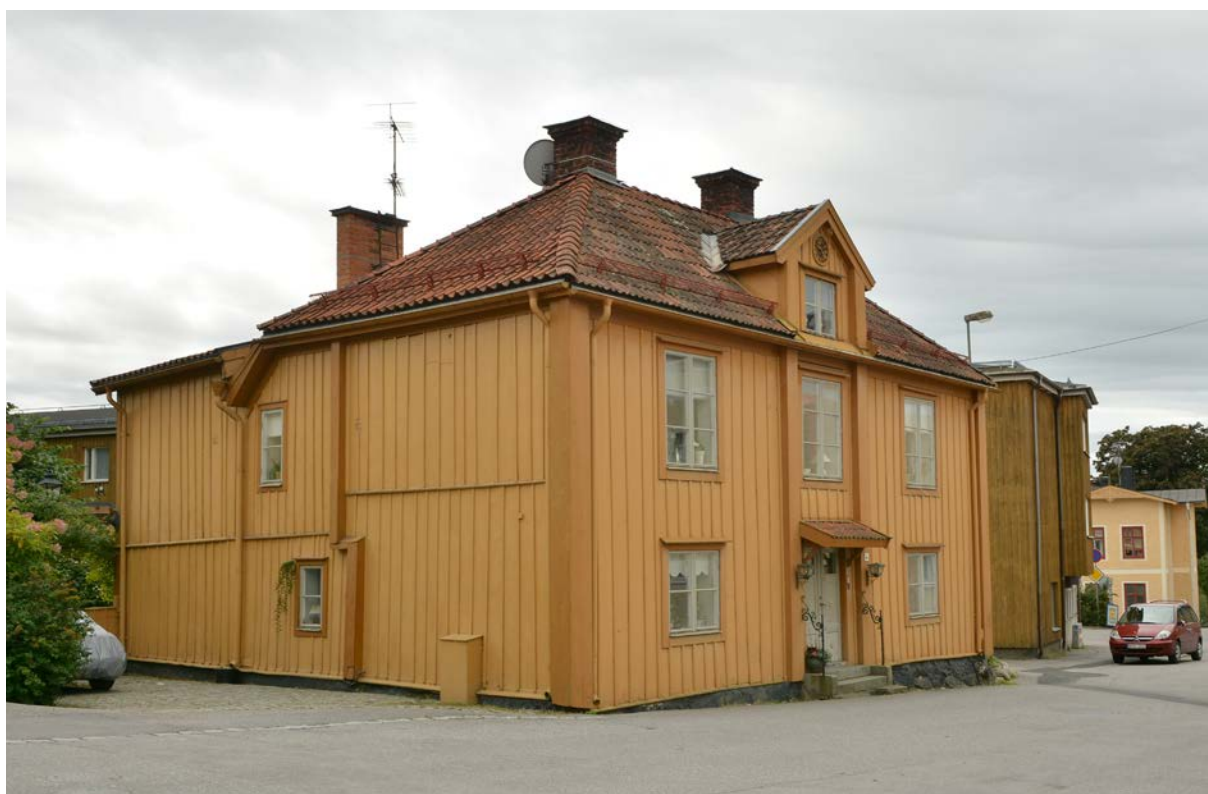
Bild 89. Gula Knutens norra och östra fasader. Lägg märke till markbeläggningen med sten (SLM D2017-0086).
