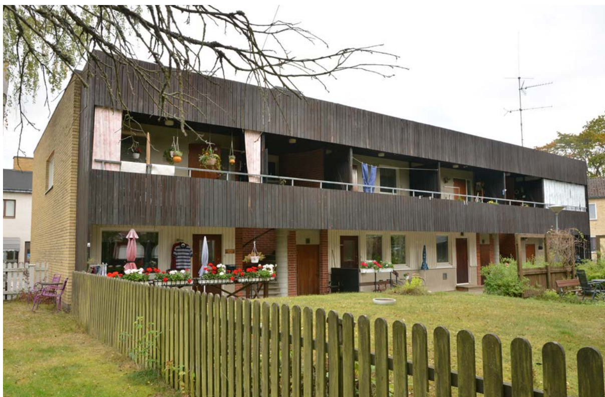
Bild 86. Södra fasaden karaktäriseras av längsgående loftgång (SLM D2017-0083).
