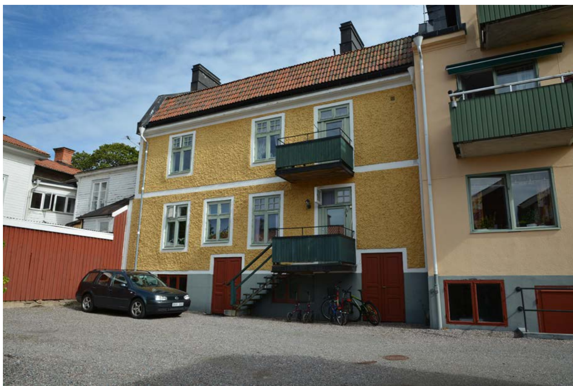
Bild 134. Södra fasaden mot gården fick balkonger, troligen vid en ombyggnad på 1930-talet (SLM D2017-0119).
