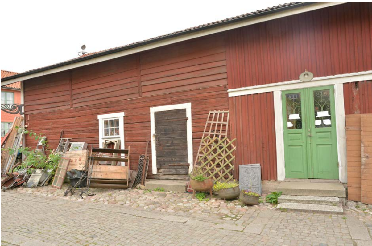
Bild 144. Hus 2 sett från gården. Lägg märke till gårdens markbeläggning med natursten. Fasaden har delvis synligt timmer stomme (SLM D2017-0129).
