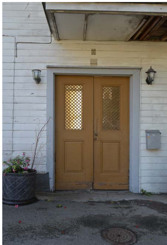
Bild 130. Entréport till trapphus (SLM D2017-0115).
