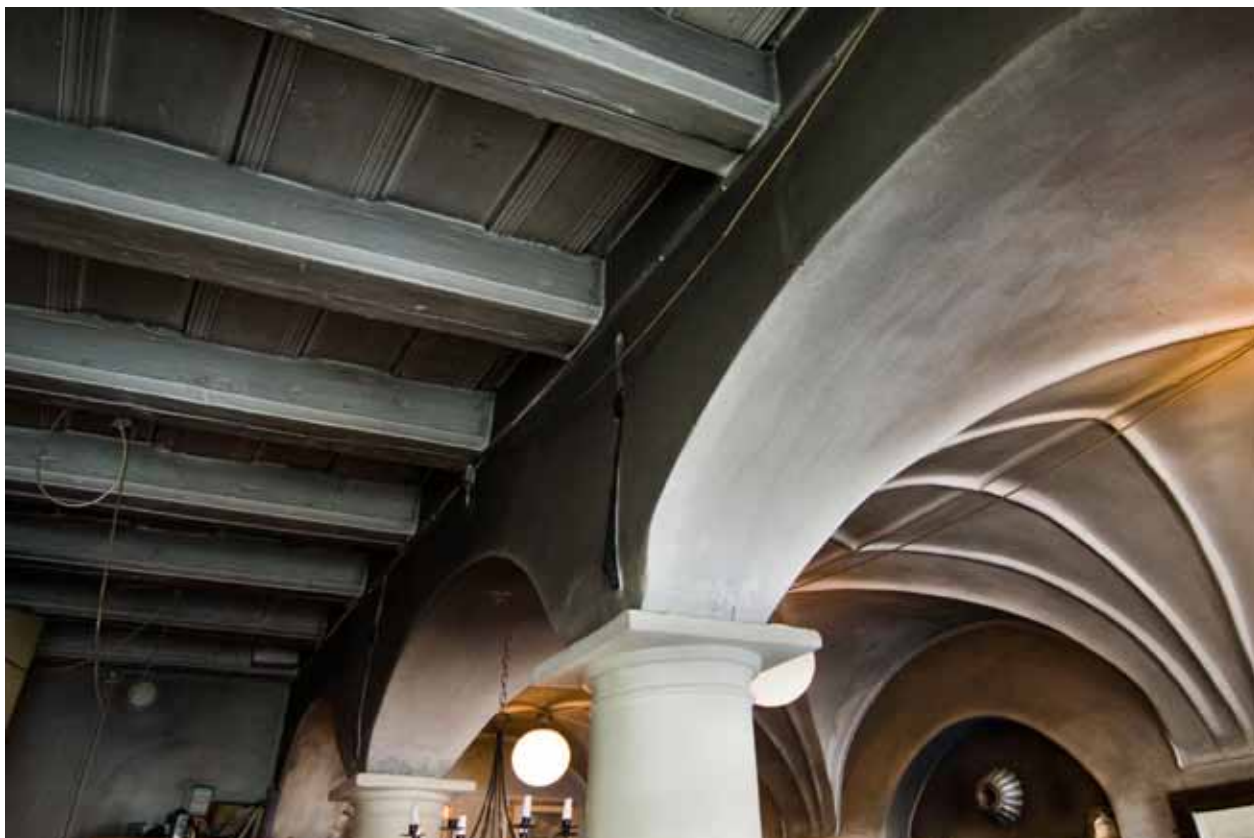
I BOTTENVÅNINGENS LOKAL I HÖRNET MOT KÅKBRINKEN BEVARAS BÅDE ETT BJÄLKTAK FRÅN EN SALUBOD OCH DEN GAMLA PORTGÅNGENS VÄLVA TAK, BÅDA FRÅN 1600-TALET. VÄGGEN MELLAN BOD OCH PORTGÅNG TOGS NER 1861 OCH ERSATTES MED PUTSADE JÄRNKOLONNER. FOTO J. MALMBERG.
