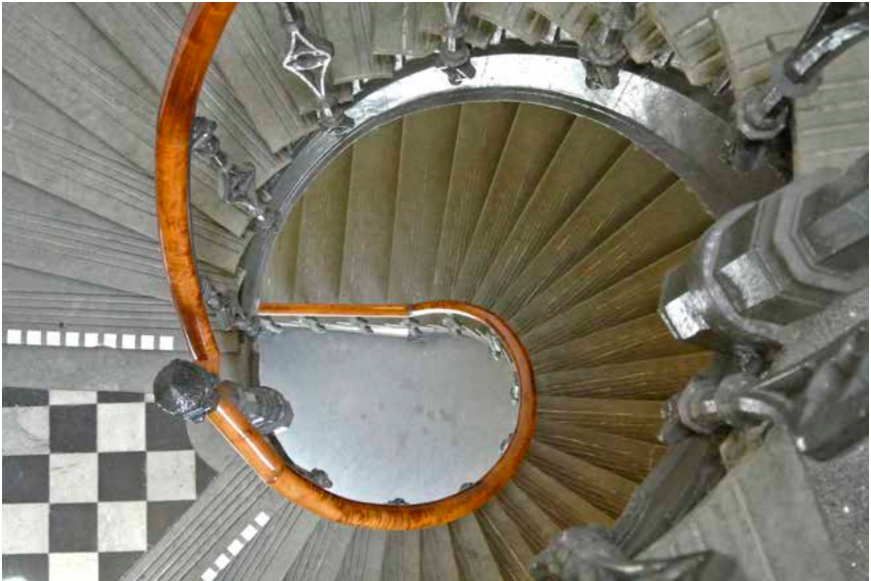
DET URSPRUNGLIGA TRAPPLOPPET AV GJUTJÄRN, STEN OCH TRÄ SETT OVANIFRÅN. FOTO: J. MALMBERG.
