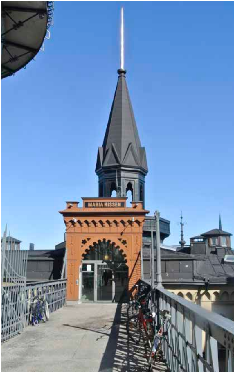
BRON ÖVER BASTUGATAN TILL HISENS ÖVERSTA VÅNING SÅGS HA PROVBELASTATS AV HJON FRÅN DILLSTRÖMSKA ARBET SINRÄTTNINGEN. FOTO: J. MALMBERG.
