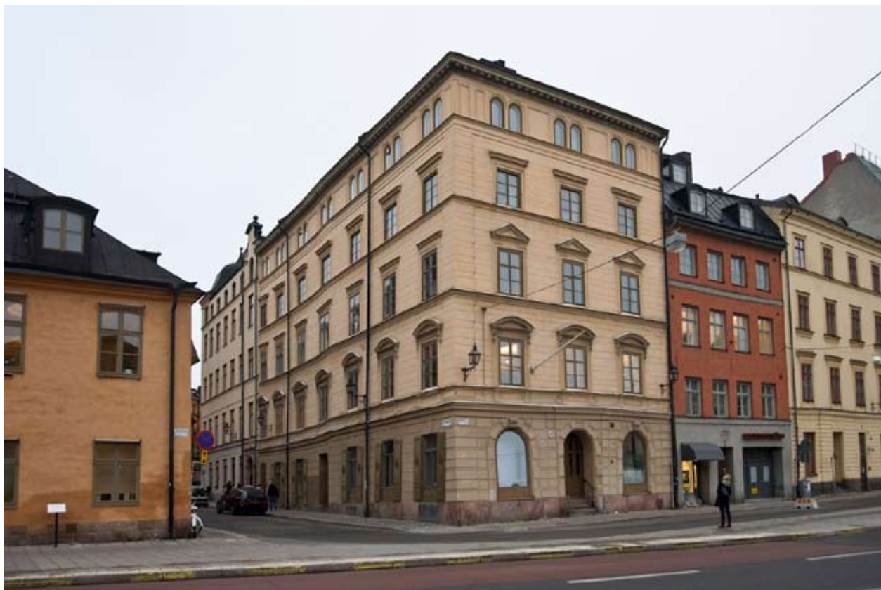
EXTERIÖREN PRÄGLAS AV EN RENOVERING OCH PÅBYGGNAD 1861 ENLIGT RITNINGAR AV J. F. ÅBOM. FASADERNA FICK ENLIGT TIDENS MODE EN PUTSDEKOR I NYRENÄSSANSSTIL. BYGGNADEN HAR GRUNDFÖRSTÄRKTS OCH SPÅREN AV SÄTTNINGAR SYNS I DEN "KNYCK" SOM FINNS I MITTEN AV FASADEN MOT STORA GRÄMUNKEGRÄND. FOTO: J. MALMBERG.
