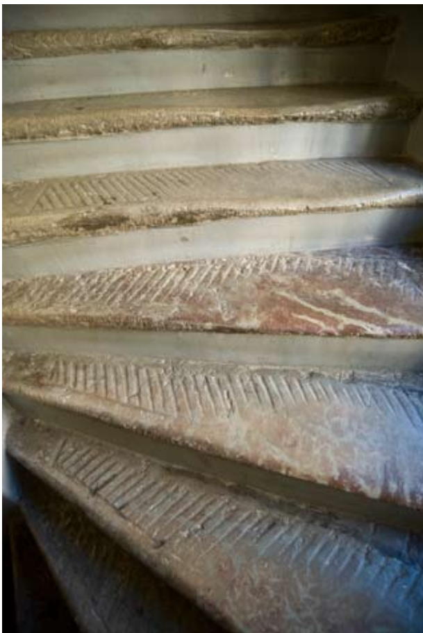
ÄLDRE KALKSTENSTRAPPA VID MUNKBROGATAN. FOTO J. MALMBERG.
