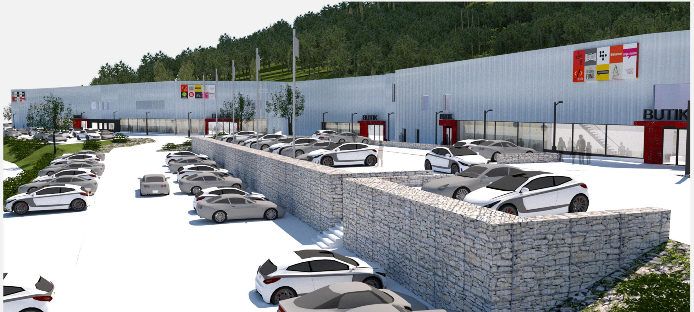
VY 13 - FASAD MOT VÄSTER
