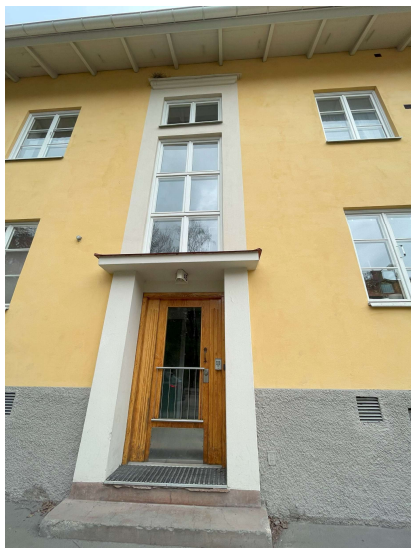
Befintliga fönster för byggnaden, 2-glas konstruktion, invändigt från lägenhet samt fasad
