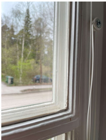
Befintliga fönster för byggnaden, 2-glas konstruktion, invändigt från lägenhet samt fasad
