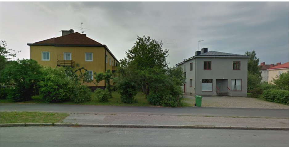
FOTO PÅ BEF. BYGGNAD SAMT BYGGNAD PÅ GRANNFASTIGHET. TAKLUTNING PÅ NYTT FÖRSLAG SAMSPELAR MED BYGGNAD PÅ GRANNFASTIGHETEN.
