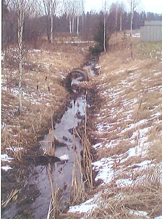
Ovan: Dike, delvis kulverterat vid gatuanslutningarna till industritomterna..
