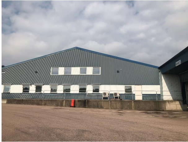
Fasad Söder skepp 3
