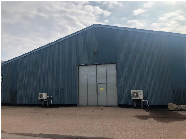
Fasad Norr, skepp 2.
