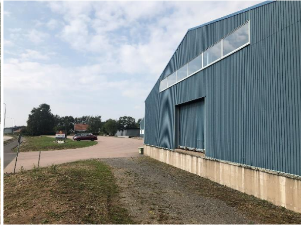
Fasad Söder skepp 5
