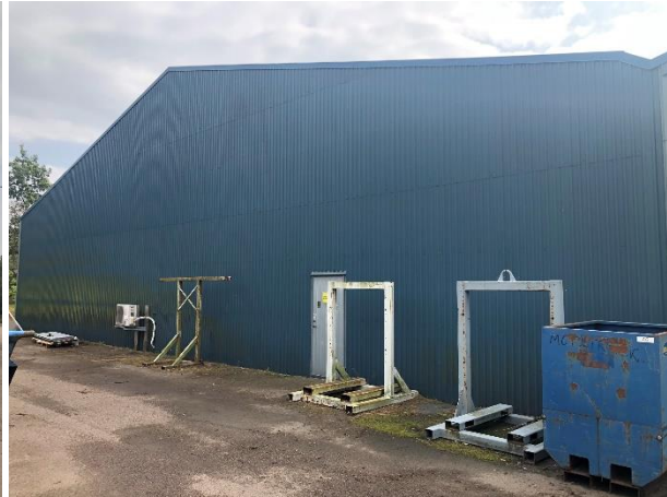
Fasad Norr, skepp 4
