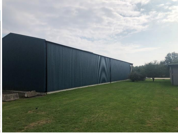
Fasad i väst, skepp 1
