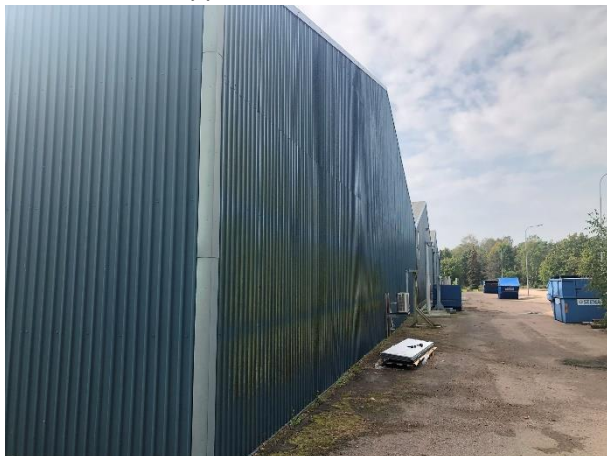
Fasad Norr, skepp 4
