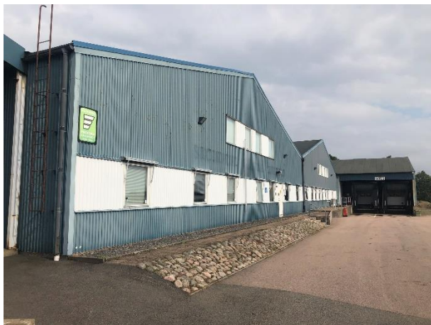
Fasad Söder skepp 2
