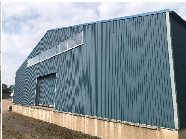
Fasad Söder skepp 5
