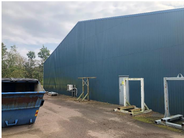
Fasad Norr, skepp 4
