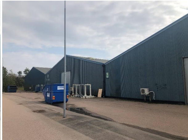
Fasad Norr, skepp 2, 3, 4
