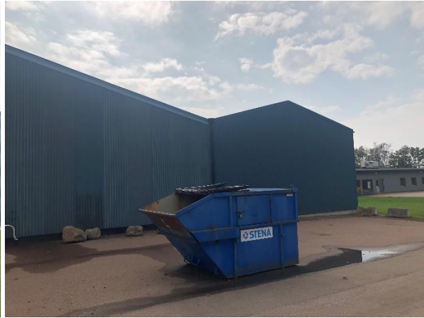
Fasad Norr skepp 1 och skepp 2
