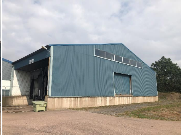
Fasad Söder skepp 5
