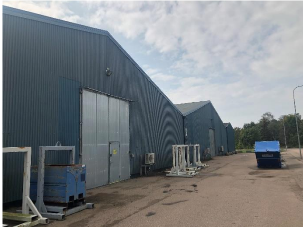
Fasad Norr, skepp 1,2,3
