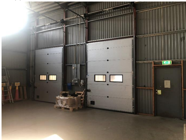
Skepp 5 portar till Lastbrygga B
