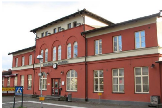
Stationsbyggnaden före och efter att den putsades.
