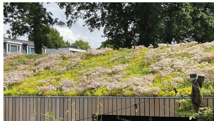
SEDUMTAK PÅ GATUKÖK/RESTAURANG
