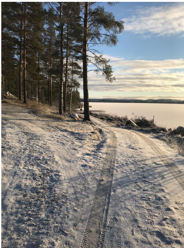
Sjuängesvägen mot sydost
