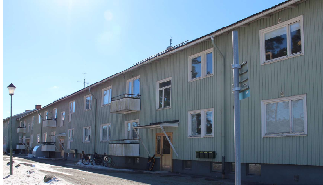
Foto från norr. Sjuksköterskehemmets östra fasad
