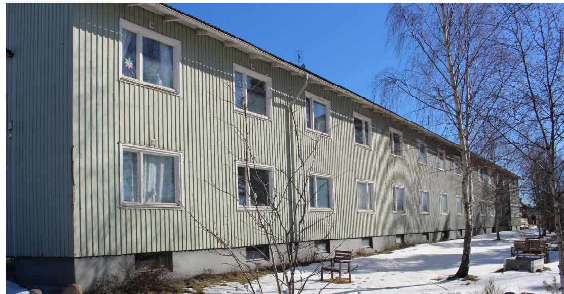
Foto från nordväst. Sjuksköterskehemmets västra fasad
