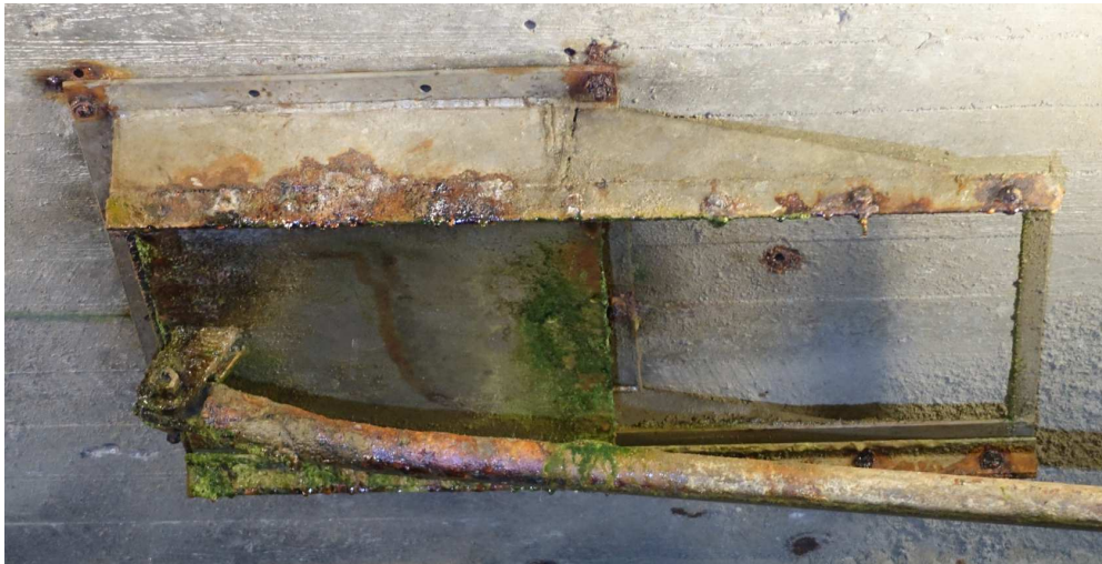
Figur 10 Foto på stålluckorna till sandschaktet.
