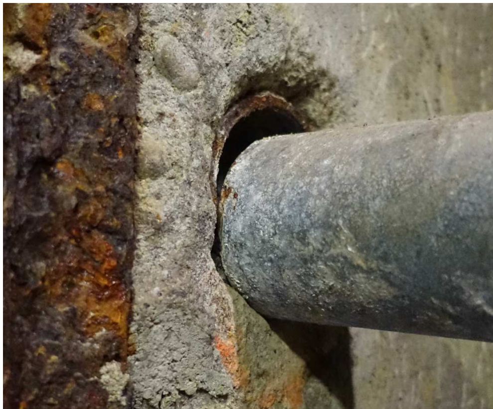
Figur 17 Närbild på löst fäste för stegstång.
