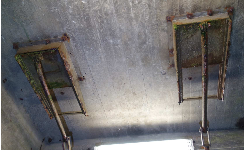
Figur 12 Foto på stålluckorna.
