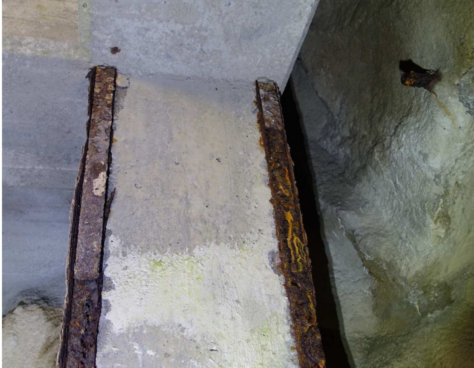
Figur 9 Foto på ståldetalj på betongpelarnas hörn.
