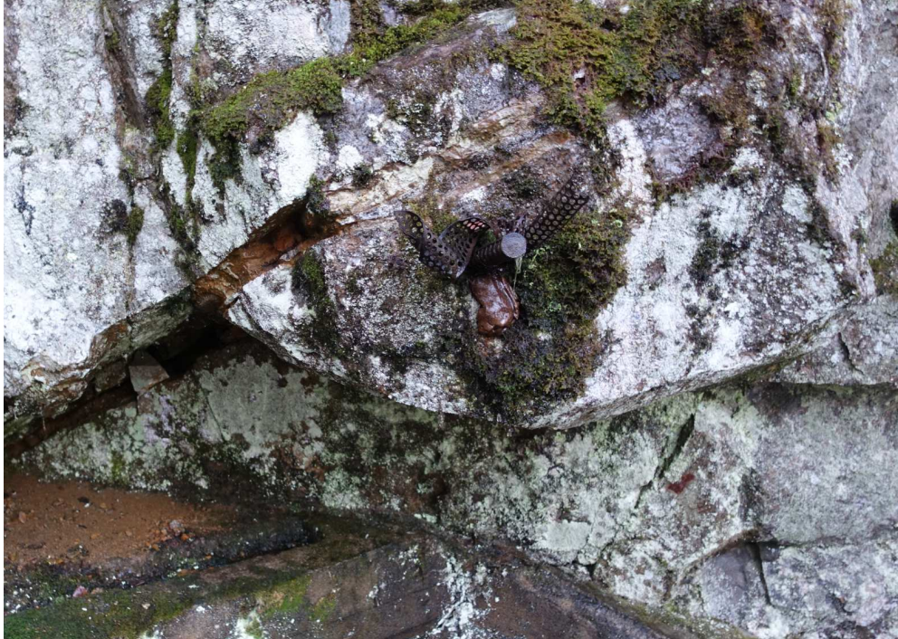
Figur 4 Löst fastbultat block ovanför port
