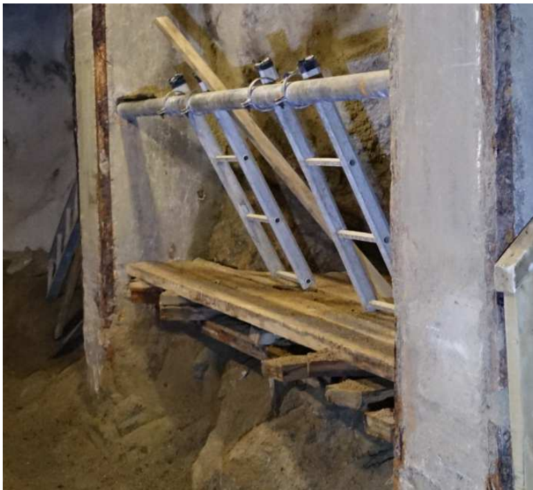
Figur 16 Bortre fäste för stång som stegarna är monterad vid är löst.
