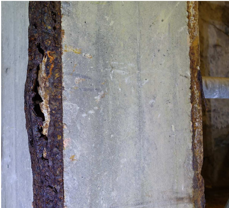
Figur 8 Foto på ståldetalj på betongpelarnas hörn.
