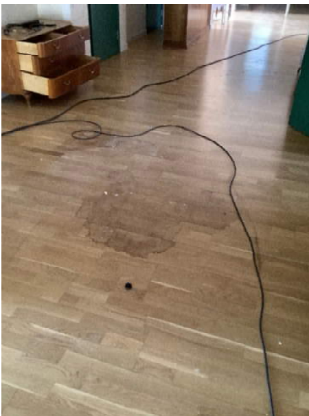
Bild 4.24: Fuktfläck på parkettgolv utan förklaring
