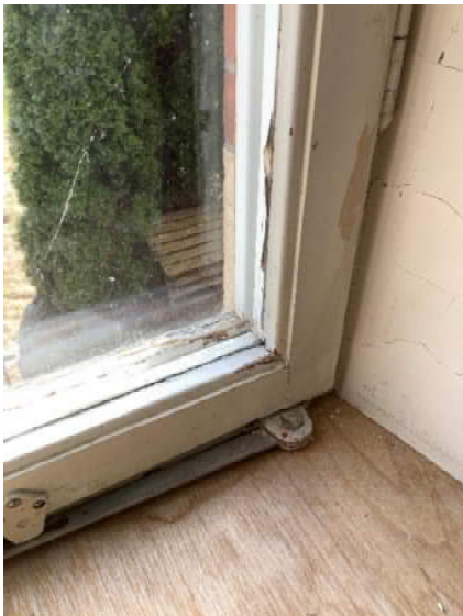
Bild 4.10: Exempel invändigt skick fönster, inget akut målningsbehov invändigt
