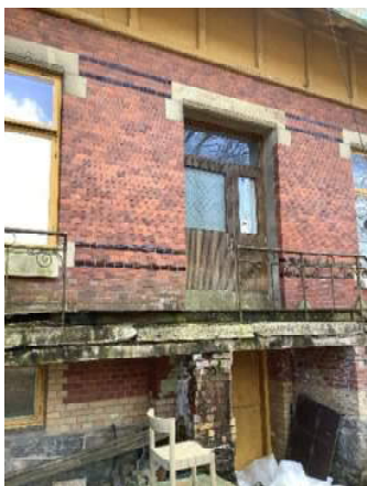
Bild 4.5: Balkong mot norr
