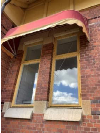
Bild 4.7: Exempel utvändigt skick på fönster
