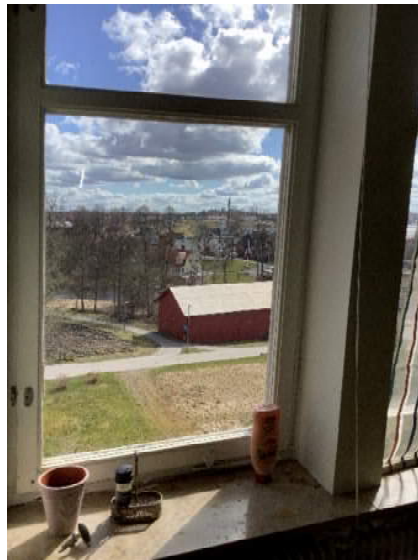
Bild 4.11: Exempel invändigt skick fönster
