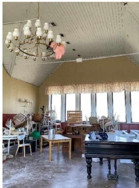
Bild 4.25: Undertak plan 2. Gipsdamm är från rivna gipsskivor från hyresgästerna.
