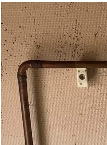
Bild 4.19: Vänstra fästet är lossat
