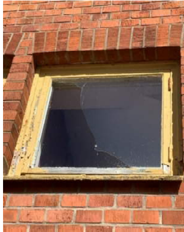
Bild 4.8: Exempel utvändigt skick på fönster
