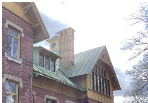
Bild 4.2: Plåttak mot norr
