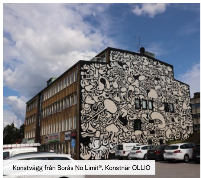
Skyltläge ut mot vältrafikerad väg
