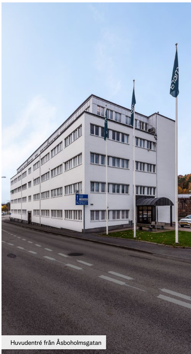
Huvudentré med rymligt trapphus och hiss
