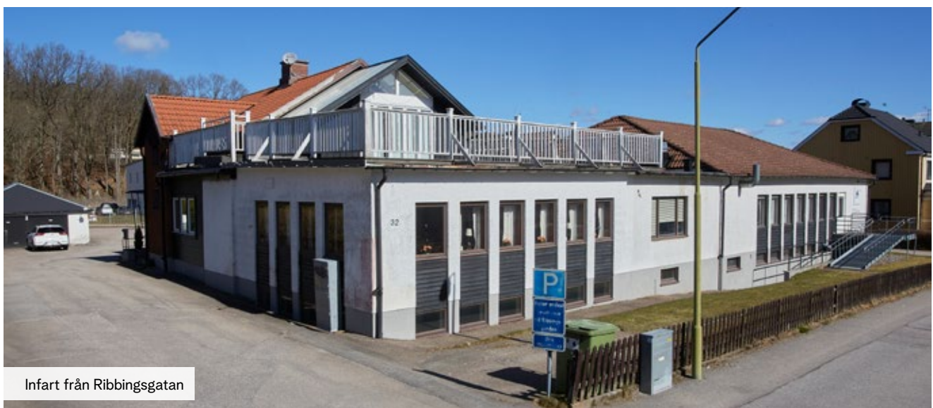
Fastighet från Ribbingsgatan
