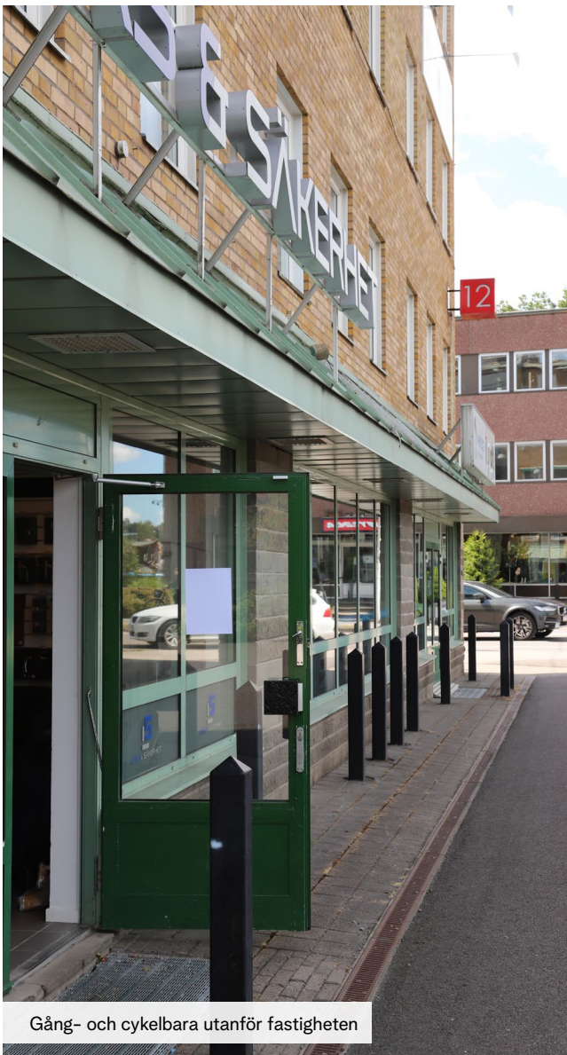
Fastigheten utmed Skaraborgsvägen
