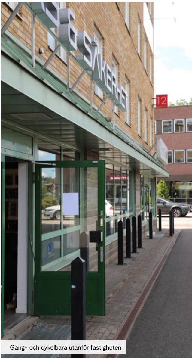
Fastigheten utmed Skaraborgsvägen
