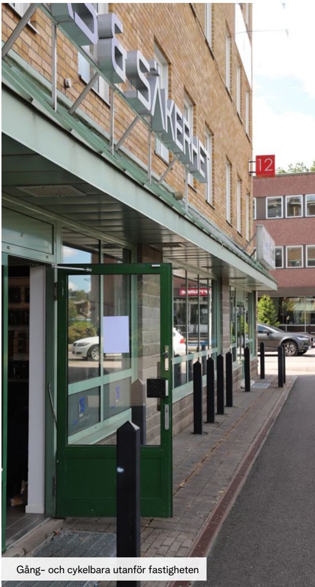
Fastigheten utmed Skaraborgsvägen
