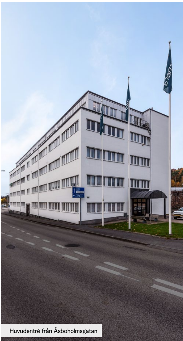
Huvudentré med rymligt trapphus och hiss
