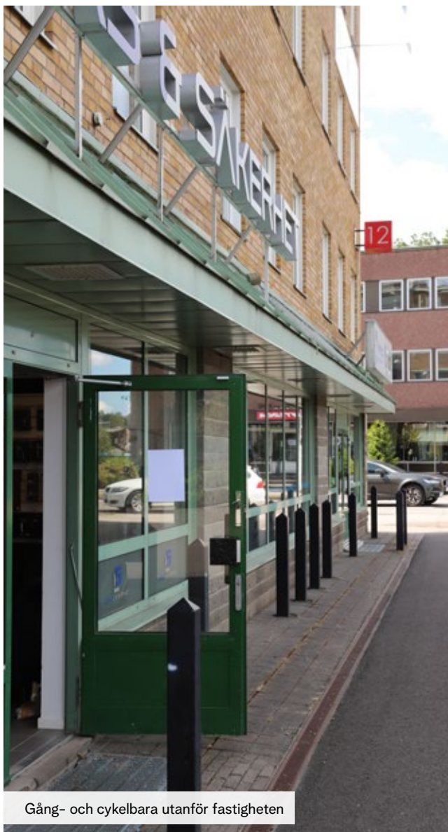
Fastigheten utmed Skaraborgsvägen
