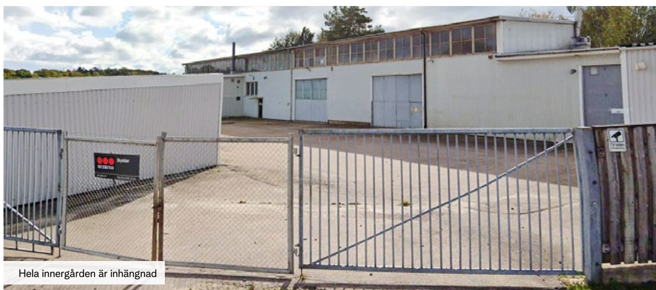
Stora portar ut mot innergården
