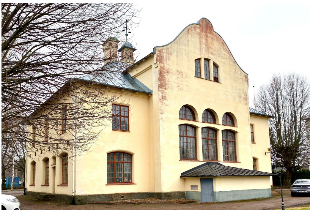
Figur 3-4. Tingshusets östra och västra fasad. Notera de många stora fönsterpartierna. Foto: Lovisa Lindberg, Länsstyrelsen i Dalarnas län.
