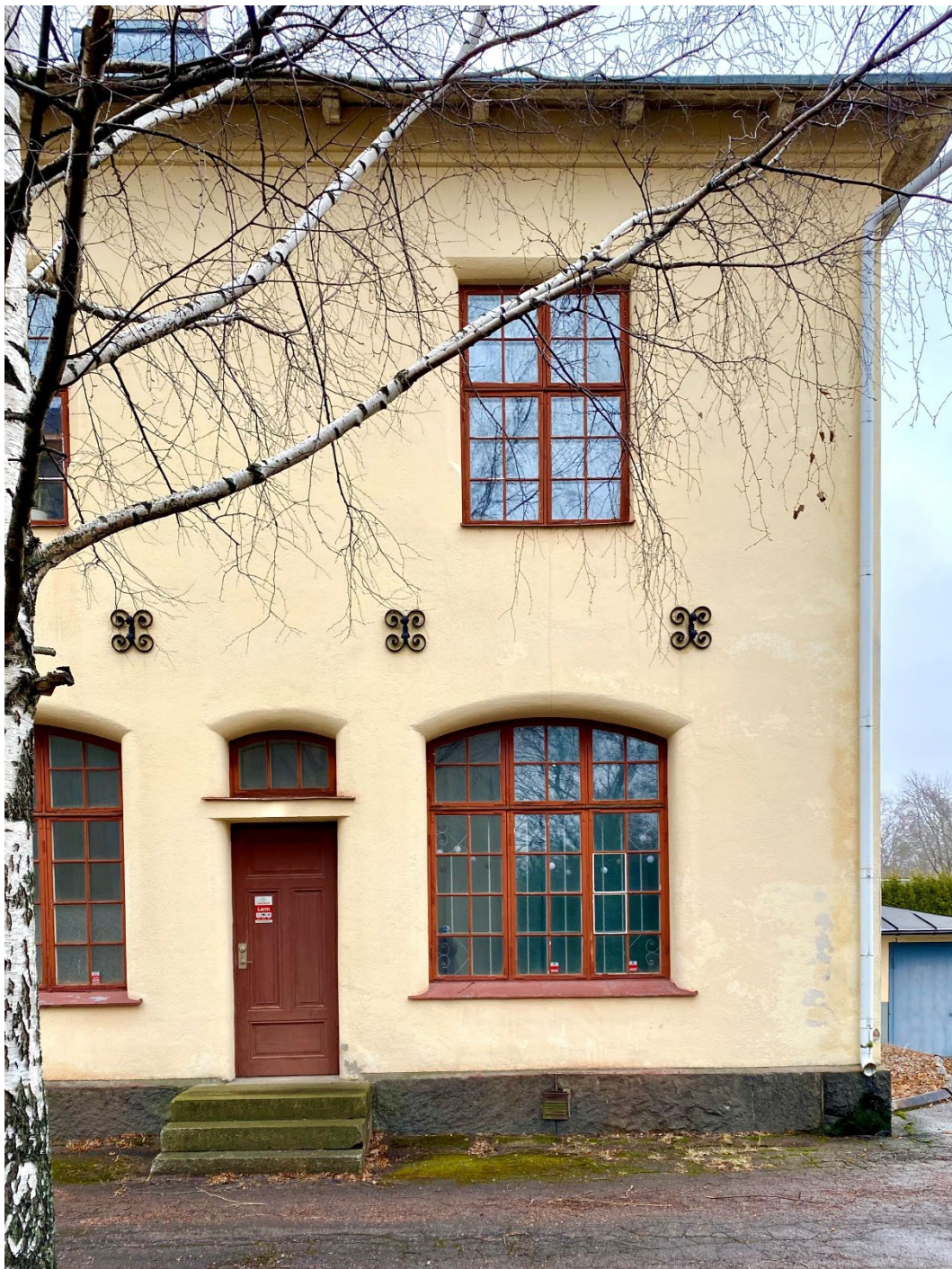
Figur 5. Tingshuset står på naturstenssockel och har slätputsade fasader med dekorativt utformade ankarslutar. Foto: Lovisa Lindberg, Länsstyrelsen i Dalarnas län.
