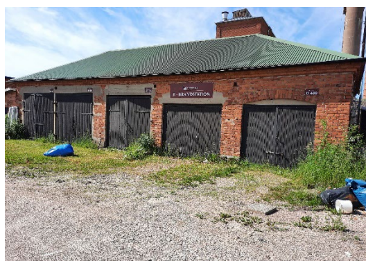
Bild 5: Garagebyggnaden. En skymt av den tillbyggda brandstationen syns till vänster i bilden.
