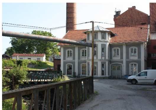
Bild 3: Ingenjörskontoret med fabrikkörstenen och panncentralen samt det gamla massakeriet i bakgrunden.
