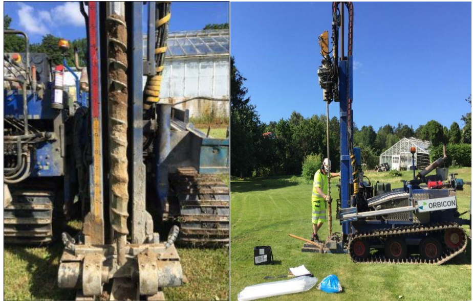
Bild 38-39. Markteknisk undersökning, skruven visar den översta metern av jordprofilen. Överst syns den mulljorden och längst ner syns den gråa siltiga leran.
