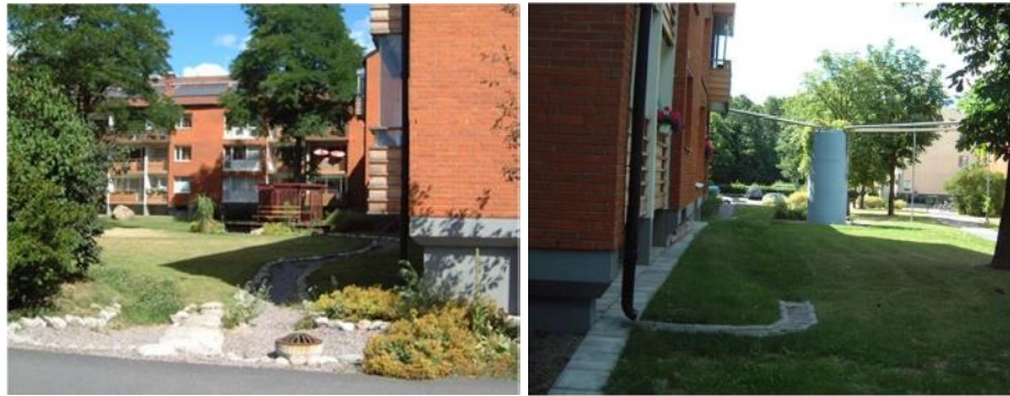
Bild 48. Avledning/infiltration via ytliga stråk, bräddutlopp via förhöjd kupolsil. Inspektoren, Kalmar
