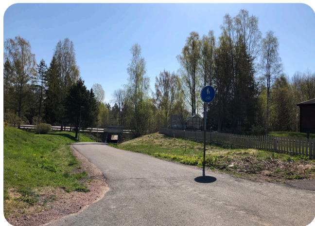
Den enda säkra kopplingen under rv 63, gång- och cykeltunnel i höjd med hembygdsgården. Den ligger dock tyvärr inte riktigt i anslutning till någon "målpunkt" som t.ex. strandpromenaden, vilket gör att många går rakt över rv 63 istället.
