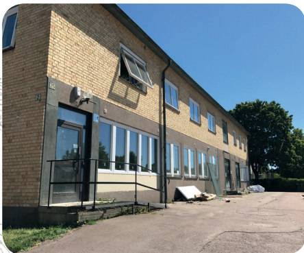
2. F.d. kommunhuset (Hammar 1:128)
